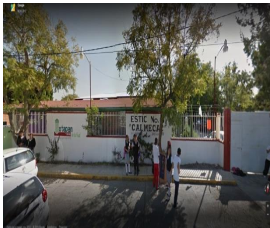
Figuras 4. Escuela secundaria Técnico Industrial No.0011 "Calmecac" de Ixtapan de la Sal
