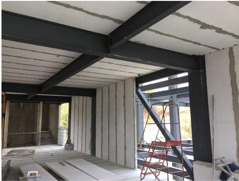
*Ilustración 46 Fotografía de los muros prefabricados/ Ilustración propia, tomada en obra.*
