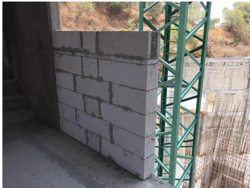
*Ilustración 45 Fotografía de los blocks prefabricados/ Ilustración propia, tomada en obra.*
