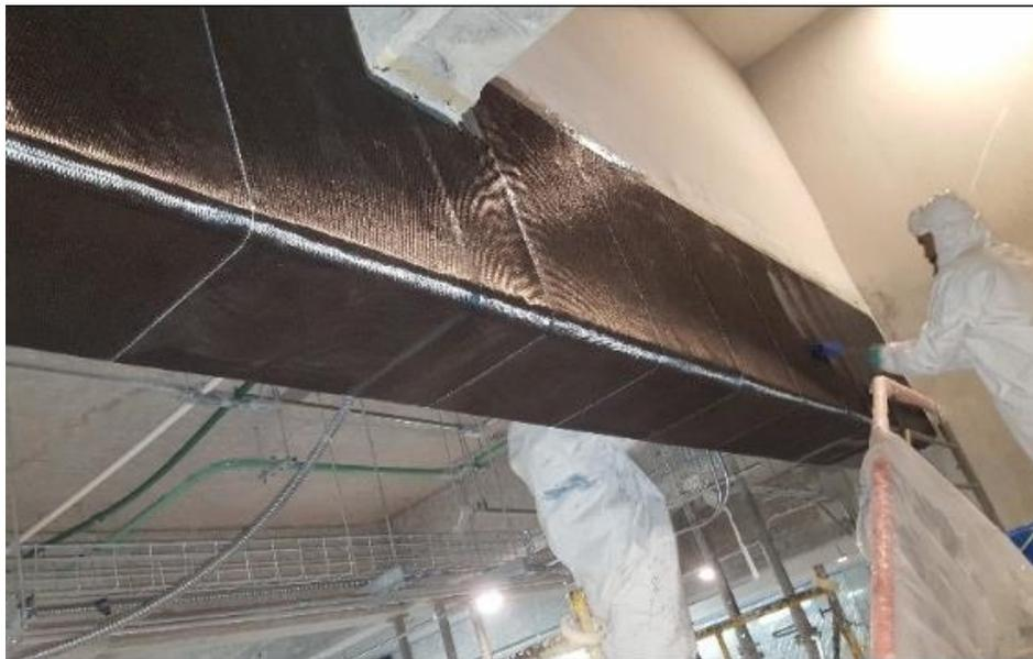
Figura 35. Trabe rehabilitada con fibra de carbono
