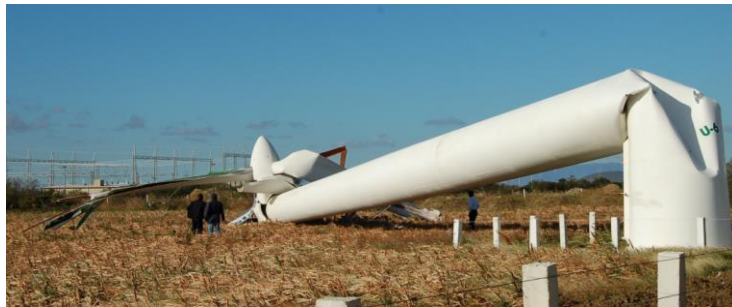
Figura 28. Accidente en aerogenerador en La Venta causado por sobre velocidad Fuente: Asamblea de Pueblos Indígenas de Istmo Oaxaqueño [31]
