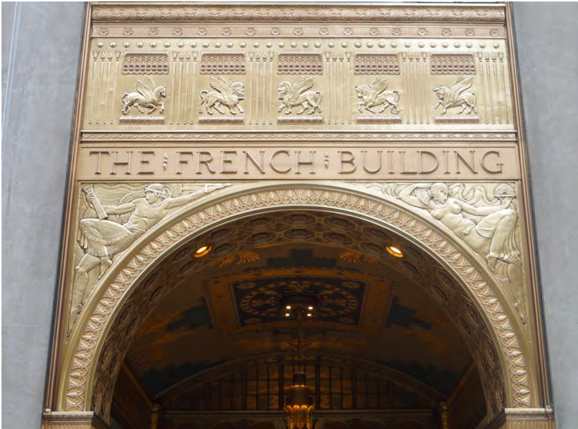
Figura 6. H. Douglas Ives y Sloan & Robertson. Fred F. French Building , 1931. Arco de entrada en bronce, detalle de fachada sur. Foto: Emiliano Pastrana, 30 de septiembre de 2019.
