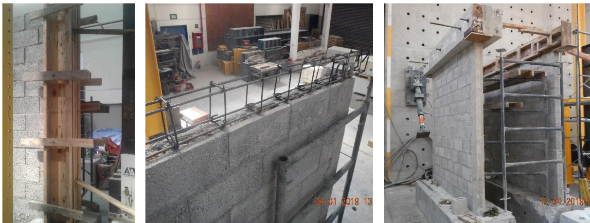
Figura 4.2 Proceso de construcción (dala y montaje)
