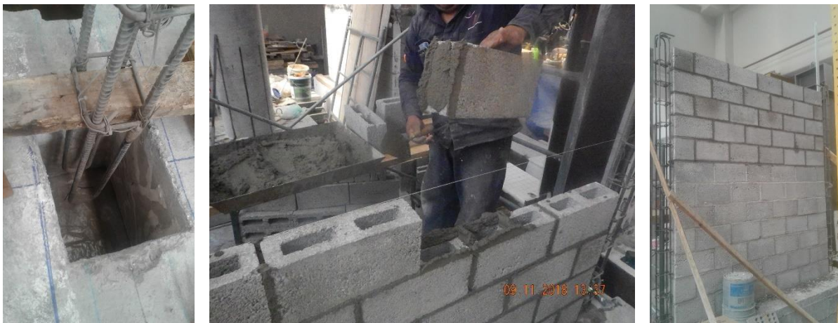
Figura 4.1 Proceso de construcción (castillos y tablero)
