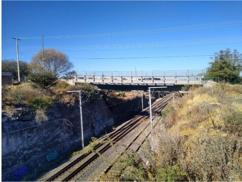
Figura 6. Paso superior de ferrocarril. Fuente: Elaboración propia.
