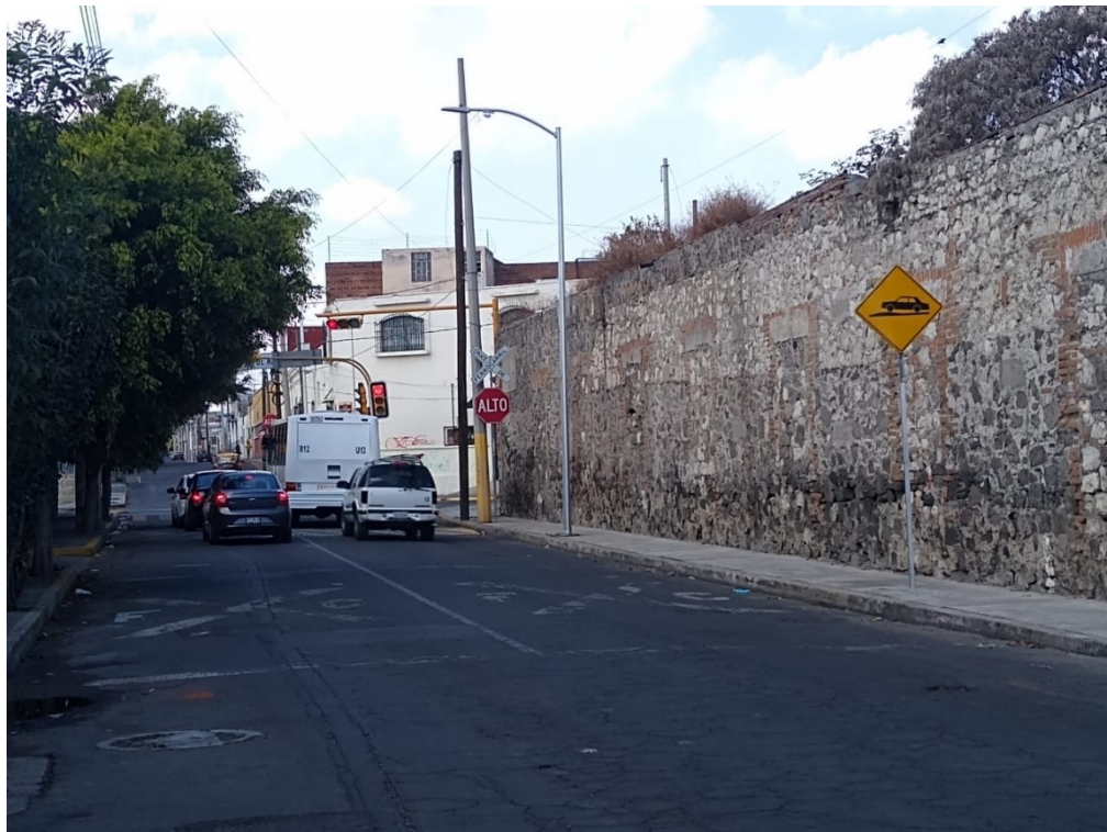
Fotografía 4. Desgaste en el señalamiento.
