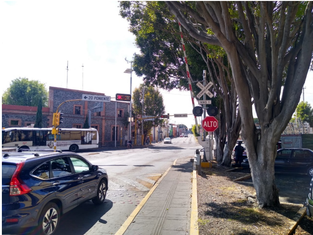
Fotografía 5. Cruce a nivel correctamente señalado.
