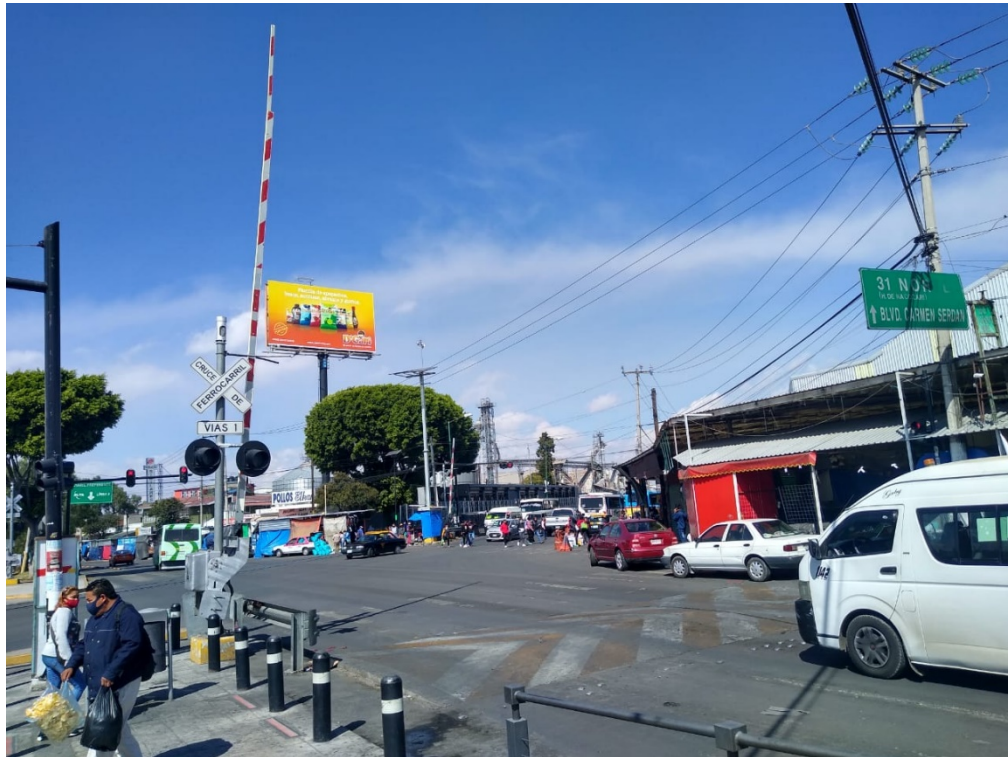
Fotografía 7. Cruce a nivel con desgaste en el señalamiento.
