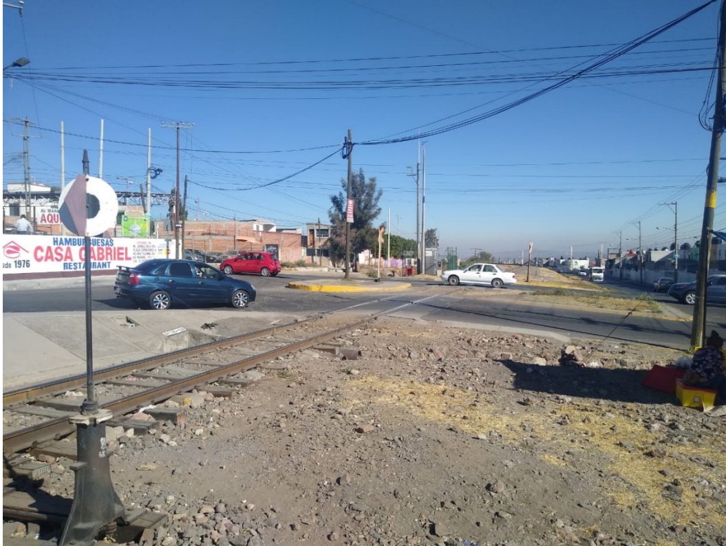
Figura 8. Cruce a nivel ferroviario. Fuente: Elaboración propia.
