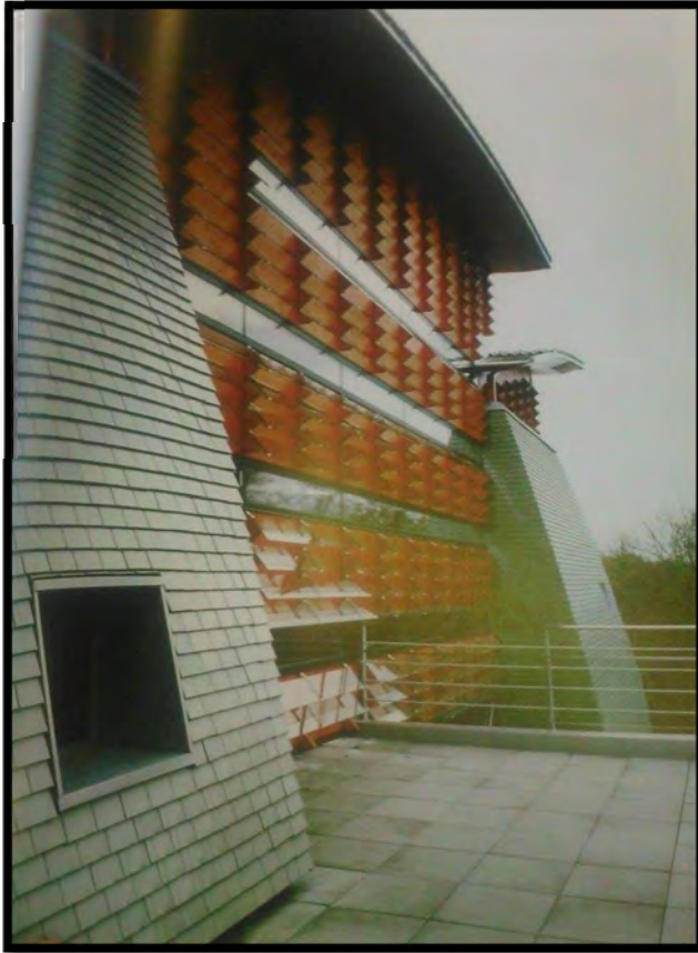
Fachada lateral . Imagen de: Architecture For Public, JaeHong lee, Uje Lee, 2003 72-9 Gonghang Gangseo Seul 157-812 Korea.
