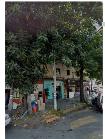
Imagen 52. Banquetas dañadas por raíces de árboles. Tomada de Google maps.
