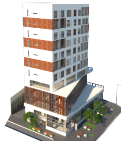
Imagen 75. Edificio Antonio Solís Elaboración propia.
