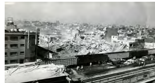
Imagen 8. Edificios derrumbados en sismo. Calz. San Antonio Abad. Tomada del Periódico “El Universal”
