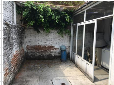
Fachada Interior Poniente
