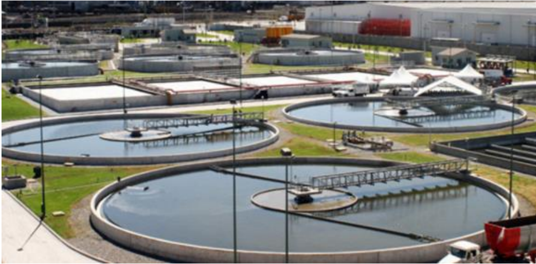
Figura 4. Planta de tratamiento de agua residual ( https://agua.org.mx/se-comprometieron-agua-a-terminar-planta-de-aguas-residuales-en-la-paz-el-independiente/ ).
