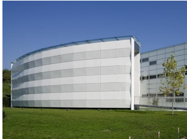
Figura 2. Fachada dinámica - Kiefer Techni Showroom Bad Gleichenberg, Austria. Paneles cerrados evitan la entrada de luz.
