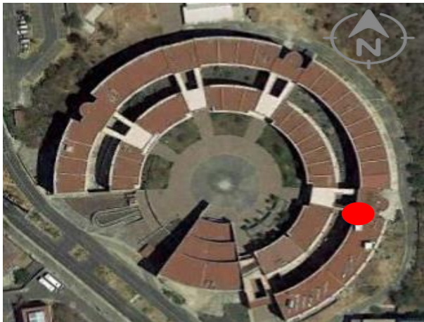
Imagen 45. Ubicación de la experimentación en el Edificio J de la Unidad de Posgrado UNAM (punto rojo).
