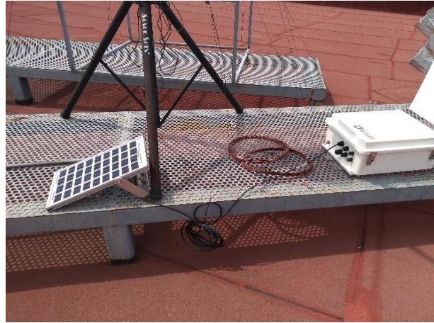
Imagen 48. Instalación de panel fotovoltaico (alimentador), datalogger y termopares.
