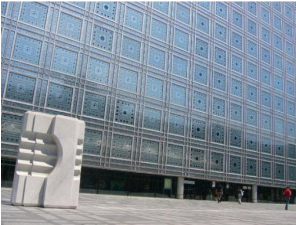
Figura 3. Fachada Instituto del Mundo Árabe - Jean Nouvel.
