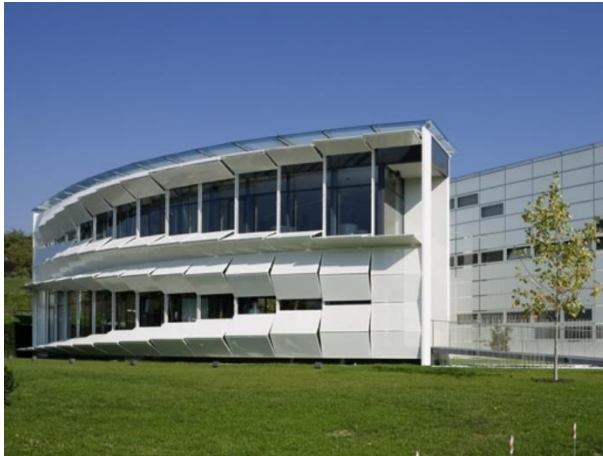
Figura 1. Fachada dinámica - Kiefer Techni Showroom Bad Gleichenberg, Austria. Paneles abiertos para la entrada de luz.
