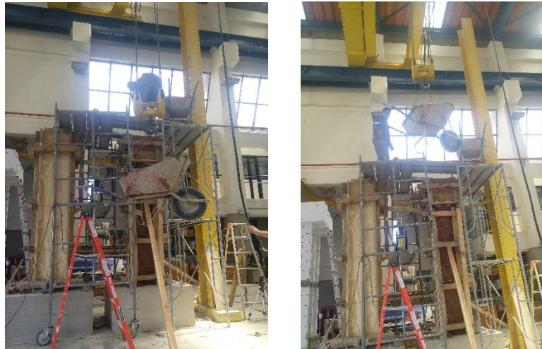
Figura 4.25.b. Colado de columna circular
