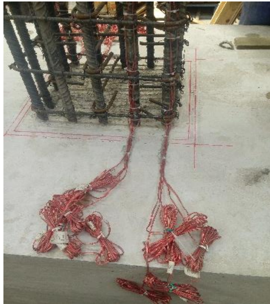
Figura 4.13. Acomodo de cables de deformímetros eléctricos
