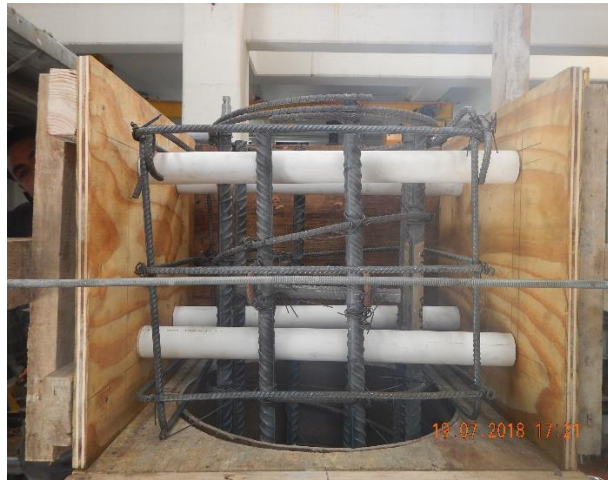
Figura 4.18. Configuración del cabezal con tubos de PVC
