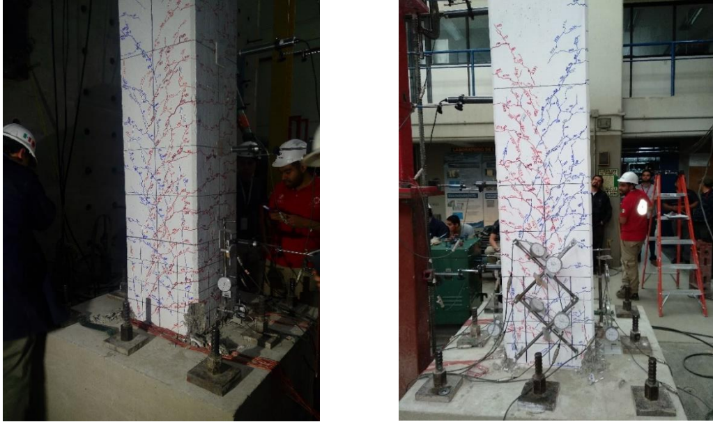
Figura 5.4. Formación y prolongación de grietas en el intervalo inelástico de espécimen MC-1
