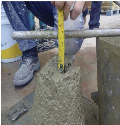
Figura 4.10. Prueba de revenimiento
