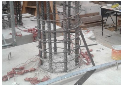
Figura 4.27. Acomodo de cables de deformímetros eléctricos
