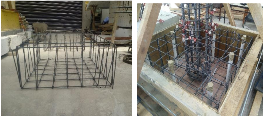
Figura 4.16. Armado del acero de refuerzo de la zapata
