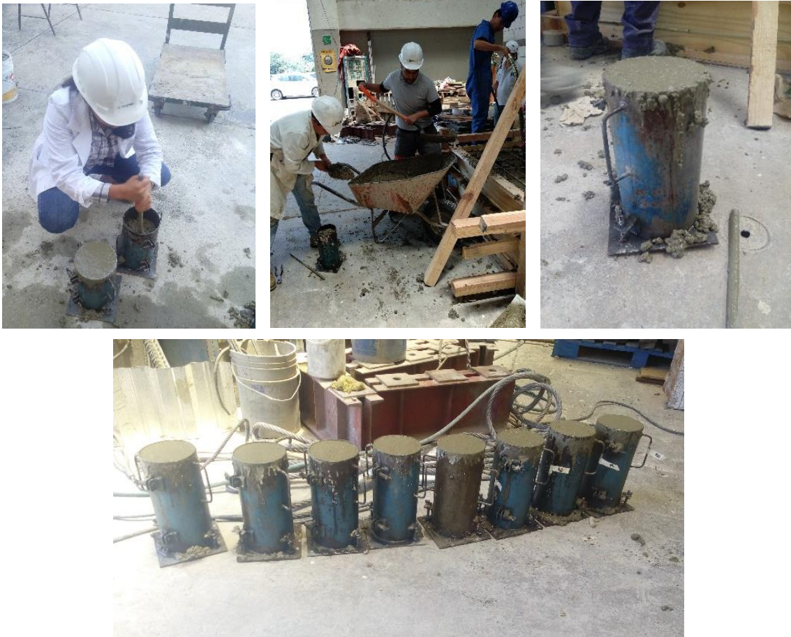
Figura 4.14. Toma de muestras de concreto para pruebas de resistencia
