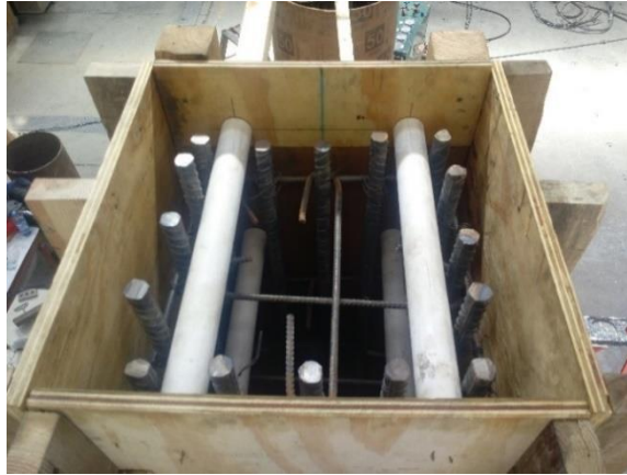
Figura 4.4. Configuración del cabezal con tubos de PVC
