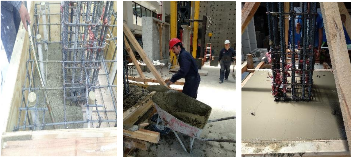
Figura 4.11.a. Colado de zapata cuadrada
