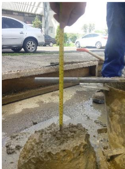
Figura 4.24. Prueba de revenimiento
