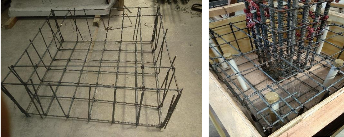
Figura 4.2. Armado del acero de refuerzo de la zapata
