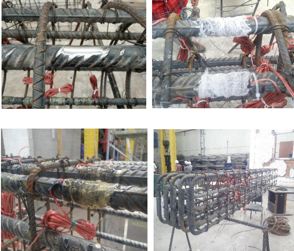
Figura 4.31. Colocación de deformímetros eléctricos en el refuerzo longitudinal del espécimen MC-1
