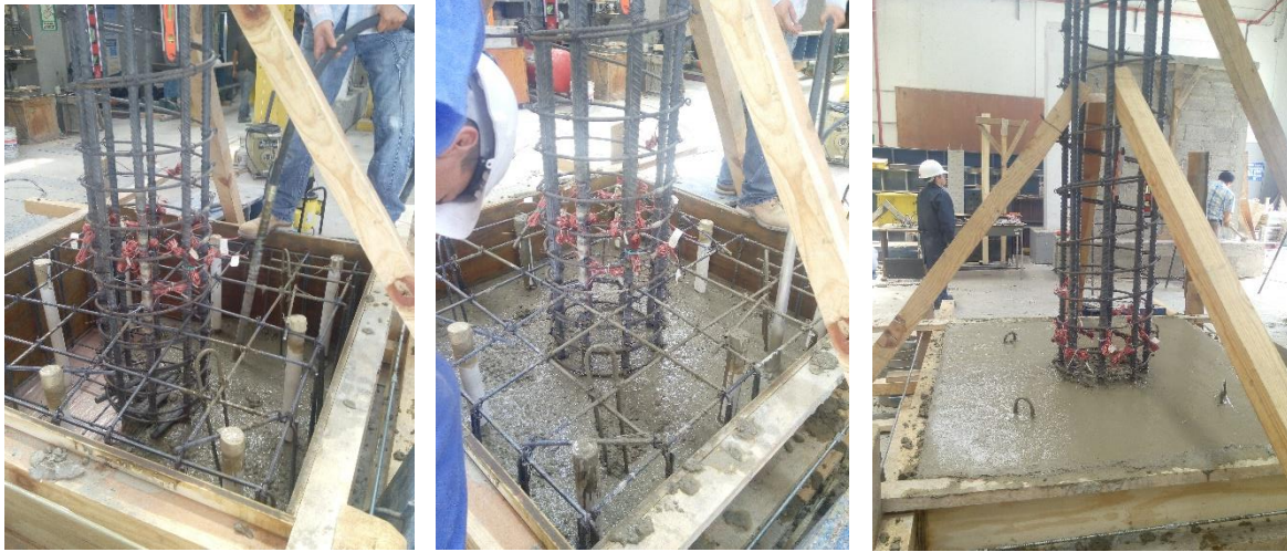
Figura 4.25.a. Colado de zapata cuadrada
