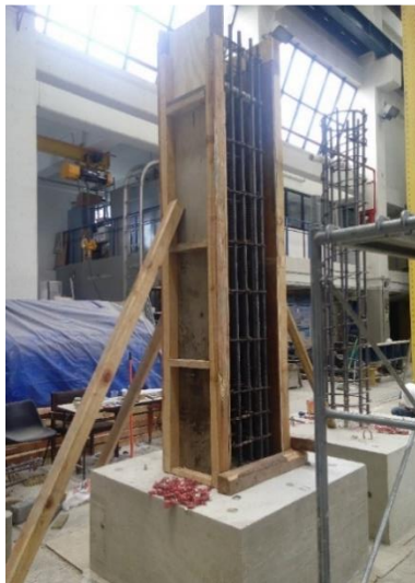
Figura 4.8. Armado de los paneles externos de la cimbra para la columna
