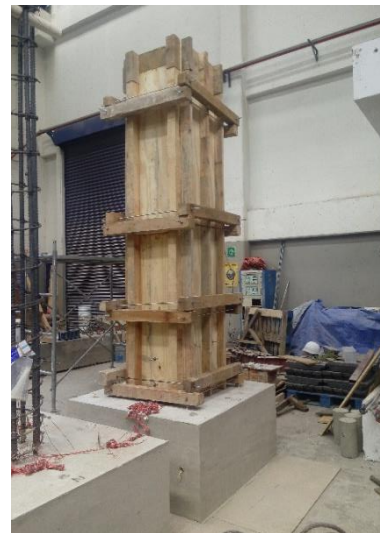
Figura 4.8. Armado de los paneles externos de la cimbra para la columna
