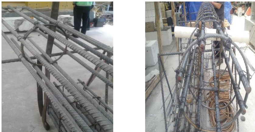
Figura 4.17. Armado del acero de refuerzo del cuerpo de la columna
