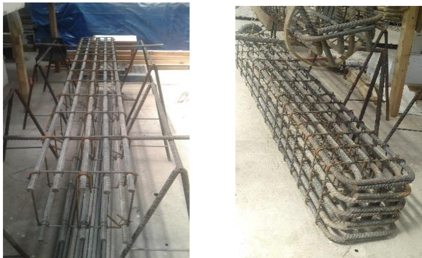
Figura 4.3. Armado del acero de refuerzo del cuerpo de la columna
