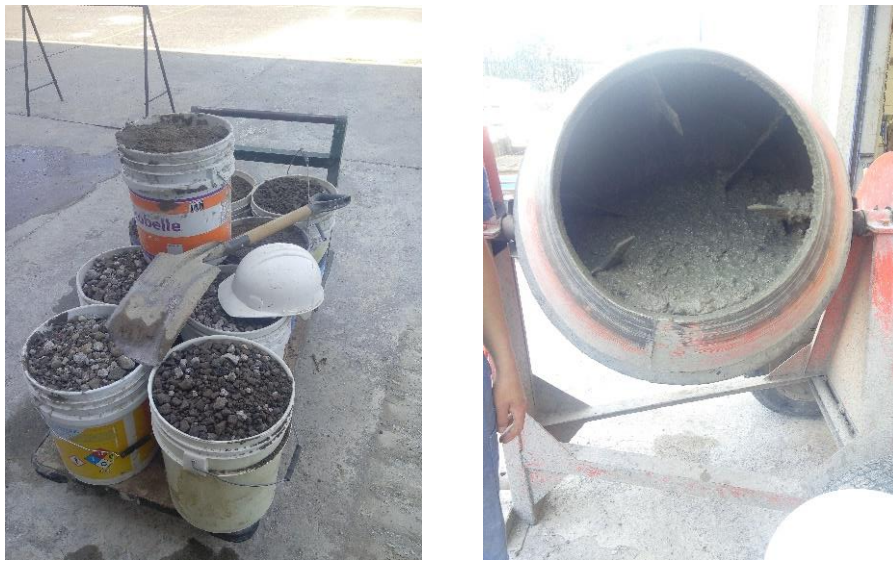
Figura 4.23. Elaboración de concreto con revolvedora
