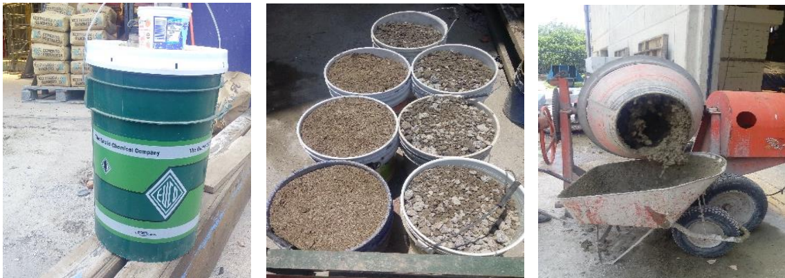
Figura 4.9. Elaboración de concreto con revolvedora
