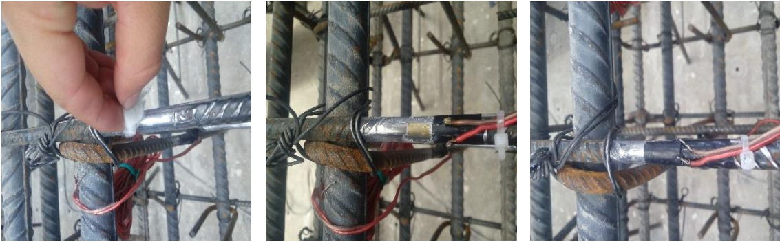
Figura 4.33. Colocación de los deformímetros eléctricos sobre el refuerzo transversal del espécimen MC-1
