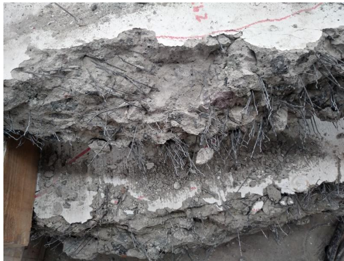
Figura 32. Distribución aleatoria de las fibras en el concreto
