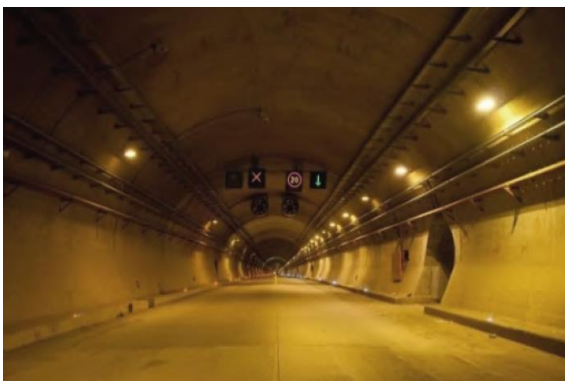
Revestimiento completo con CRF. Carretera Durango-Mazatlán, México
