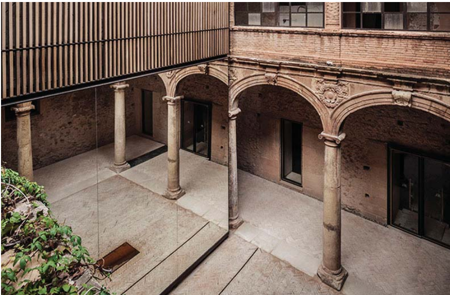
Villalba, M. (2014). Palau-Castell. Betxí /// Recuperación claustro [Fotografía]. El fabricante de esferas. http://web.elfabricantedeesferas.com/palaucastellbetxi/
