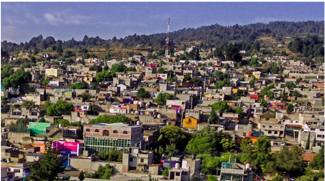
La topografía como obstáculo en la dotación de servicios. Archivo de Carlos Ruiz
