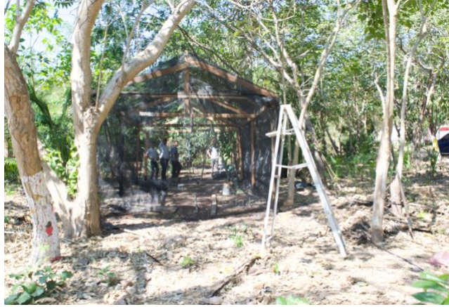
ILUSTRACIÓN 3. Construcción de la casa sombra en las instalaciones de la preparatoria.
