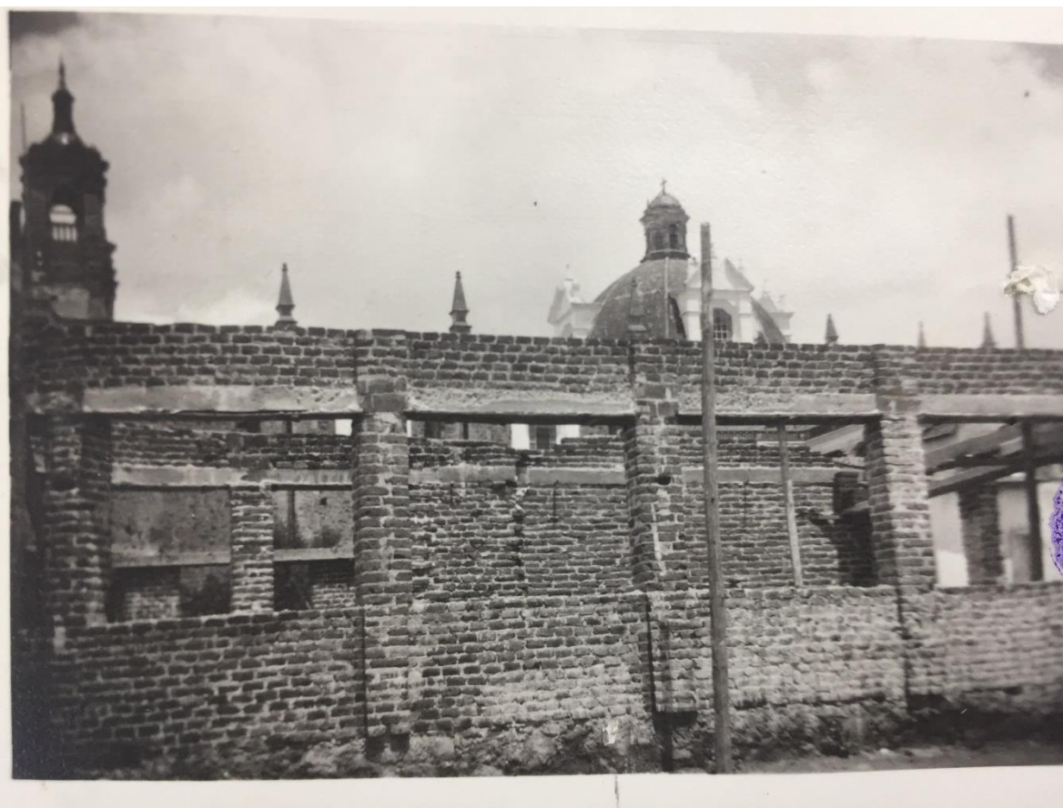
Imagen 40.- Construcción de una escuela en Villa Cuauhtémoc.
