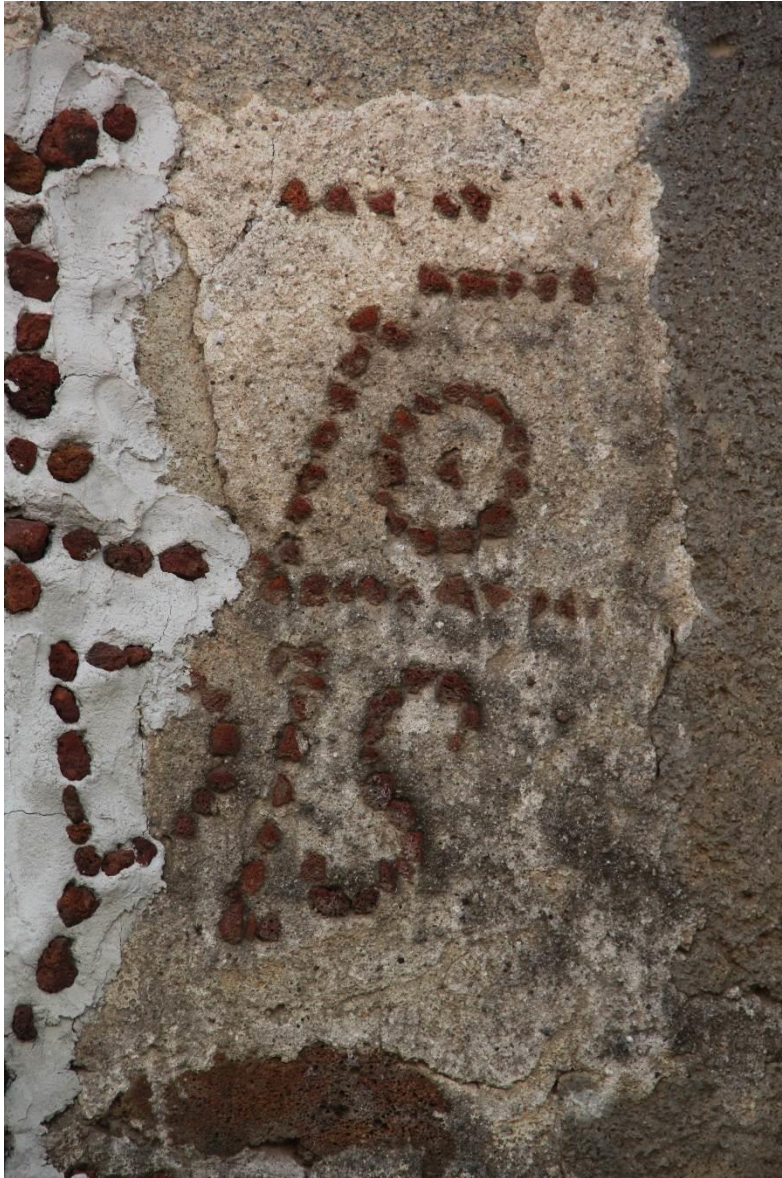
Imagen 53.- Rajueado con forma del crismón Parroquia de San Bartolomé Apóstol, Otzolotepec, Estado de México Imagen: ARA, 2021.
