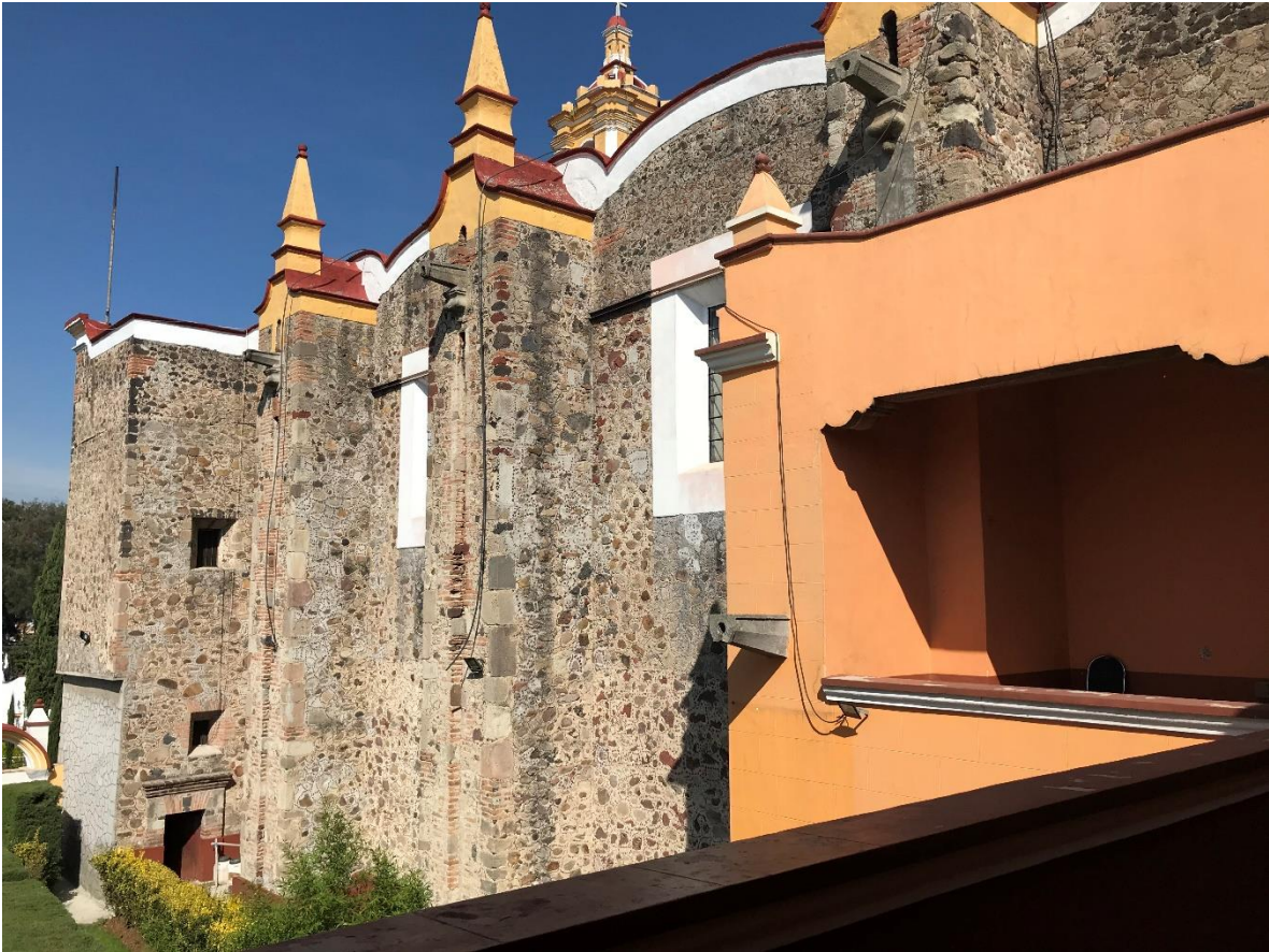
Imagen 29.- Muro sur de la parroquia de San Bartolomé Apóstol, Oztolotepec, Estado de México (primeros tres tramos). Imagen: ARA, 2021.
