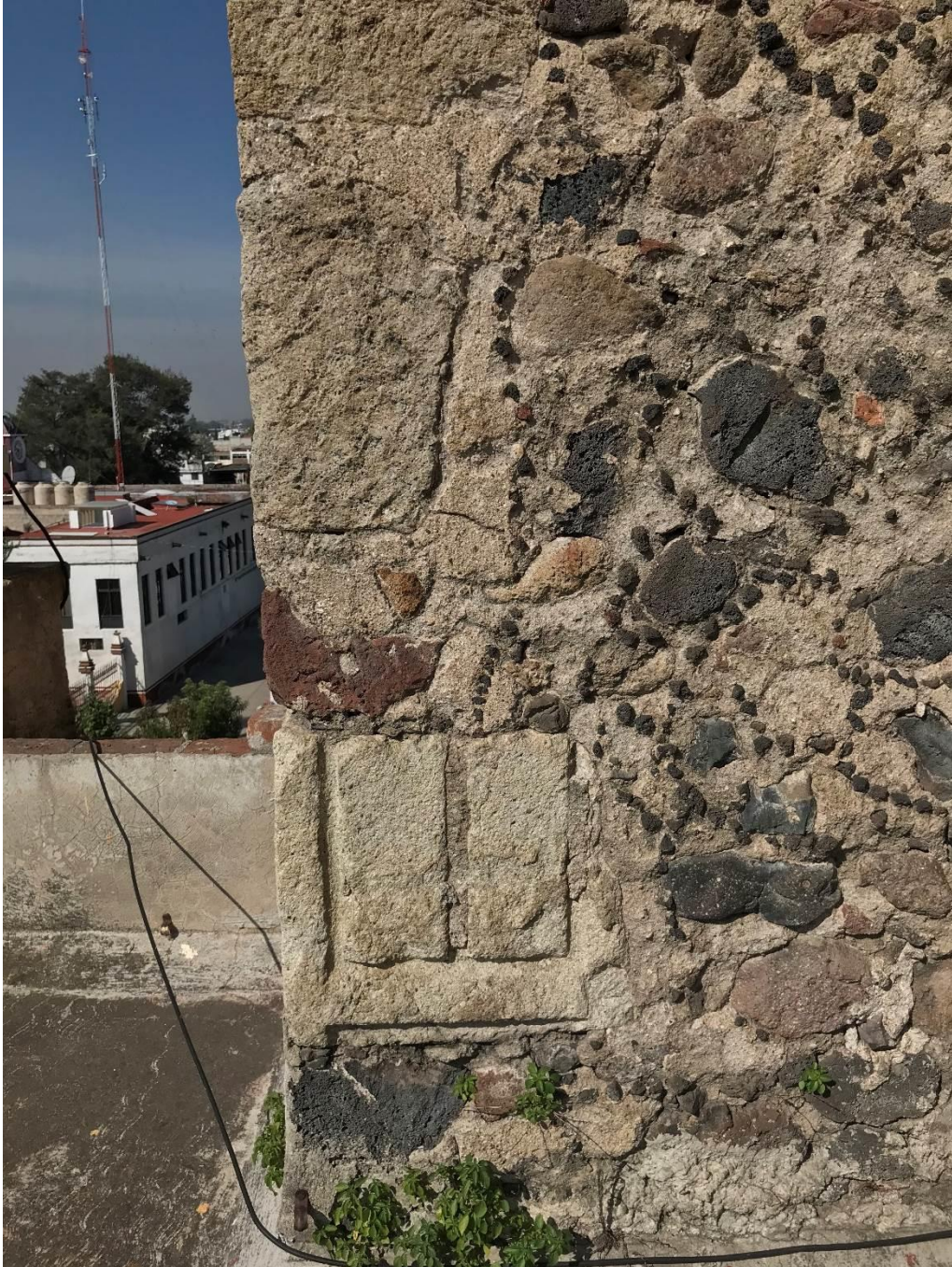
Imagen 31.- Detalle de contrafuerte hecho con materiales reciclados, parroquia de San Bartolomé Apóstol, Ocotlán, Estado de México. Imagen: ARA, 2021.
