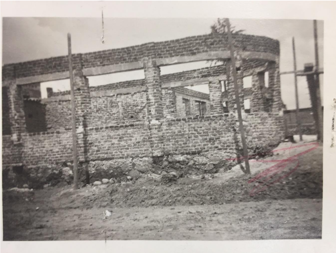
Imagen 42.- Construcción de una escuela en Villa Cuauhtémoc. 1941.
