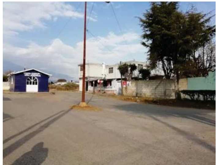
Figura 45. Este tramo colindante al conjunto Esperanza se encuentra en un grado de contaminación por basura mayor. Lo que lo hace ver como un basurero y la falta de cultura higiénica de los pobladores. Fuente: Elaboración de la autora.
