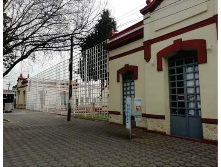
Figura 15. Casa de Cultura de Esperanza. La Casa de Cultura de Esperanza tiene dos principales volúmenes, y un patio para la realización de actividades, sus fachadas se encuentran desgastadas y no hay asistencia de la gente, ya que se encuentra fuera de funcionamiento. Fuente: Elaboración de la autora, Leslie M. Zamarripa Jiménez.
