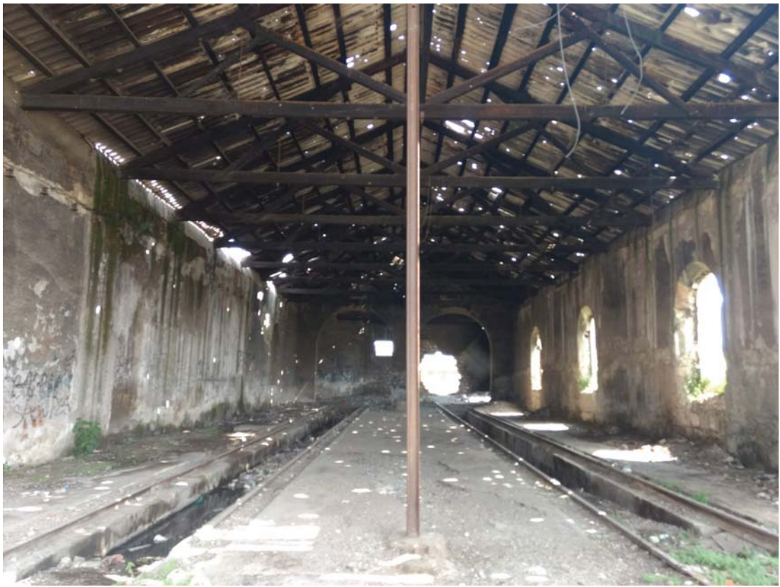
Figura 74. Interior de Casa de máquinas. Fuente: Elaboración de la autora.
