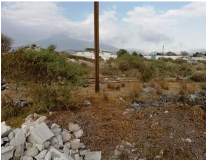
Figura 44. En esta fotografía se puede observar uno de los accesos del conjunto, la calle 12 Ote. Esta calle cuenta con contaminación de basura, así como vegetación nociva. Aún se puede encontrar en el conjunto, antenas y postes de luz con material de las vías. Fuente: Elaboración de la autora.
