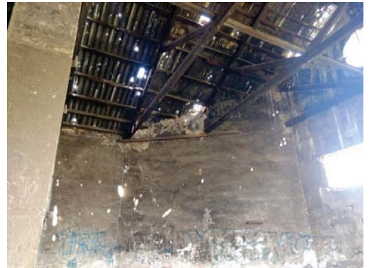
2. Muros vandalizados con graffitis.
