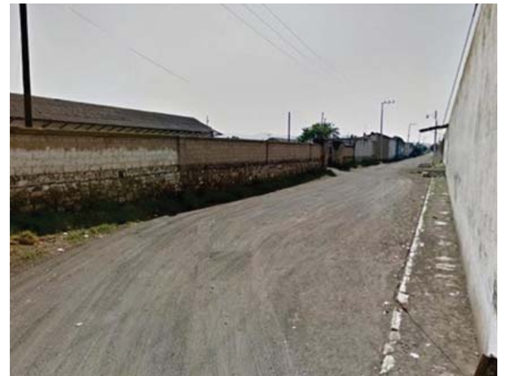
Figura 49. Estas calles próximas al conjunto se encuentran deterioradas, con falta de infraestructura urbana, aunque el flujo de personas y automóviles no es frecuente, son necesarias las mejoras en calidad urbana. Fuente: Elaboración de la autora.
