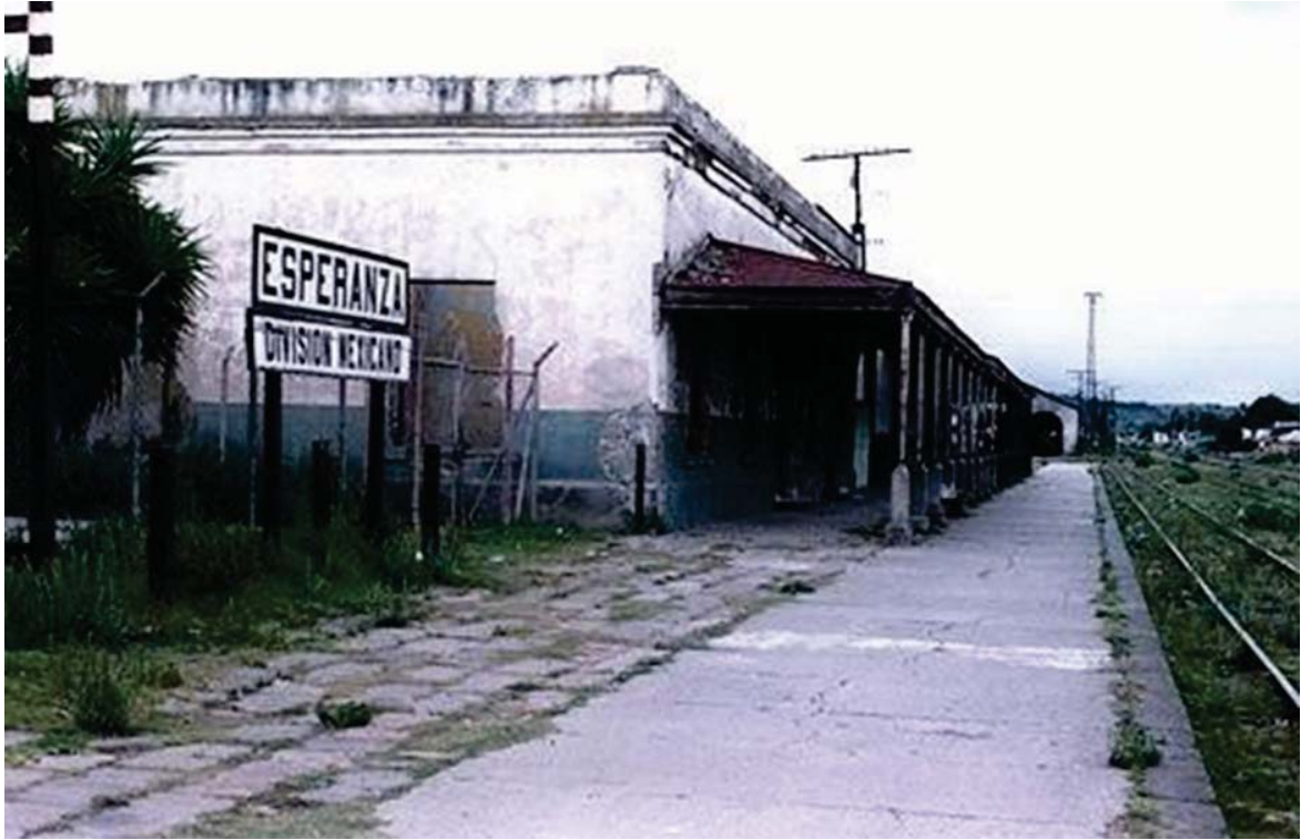
Figura 10. Fachada principal y lateral derecha del hotel. Fuente: Autor desconocido, Sin año, Sin nombre, Fotografía, Recuperado: Sistema de Información Cultural, Patrimonio Ferrocarrilero.
