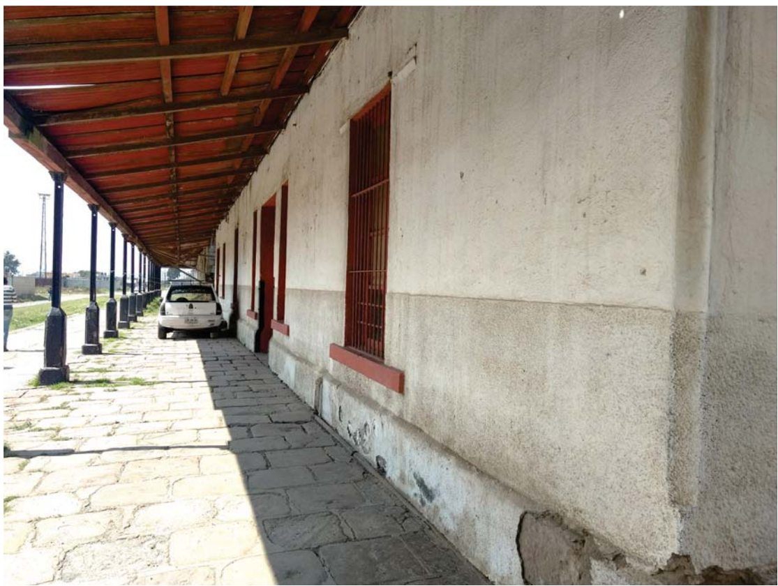
Figura 67. Fachada frontal- Estación Esperanza. Fuente: Elaboración de la autora.
