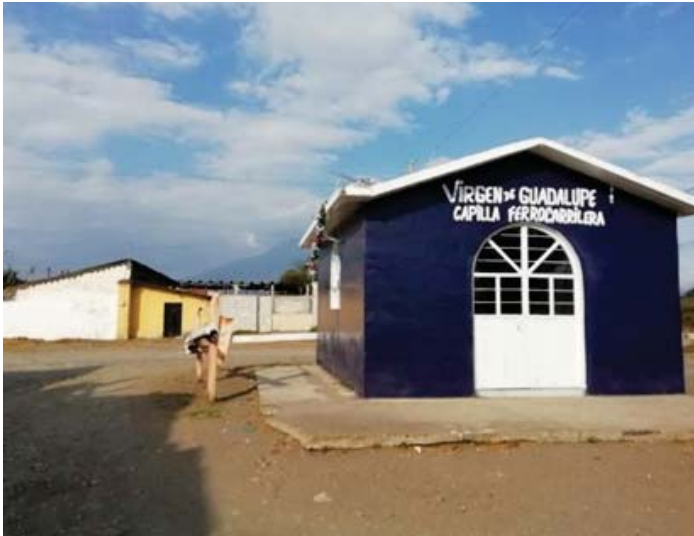
Figura 42. Algunas viviendas añadidas al conjunto Esperanza, se encuentran en estado de obra negra, lo cual nos habla de una falta de planeación al realizar estas estaciones. Fuente: Elaboración de la autora.
