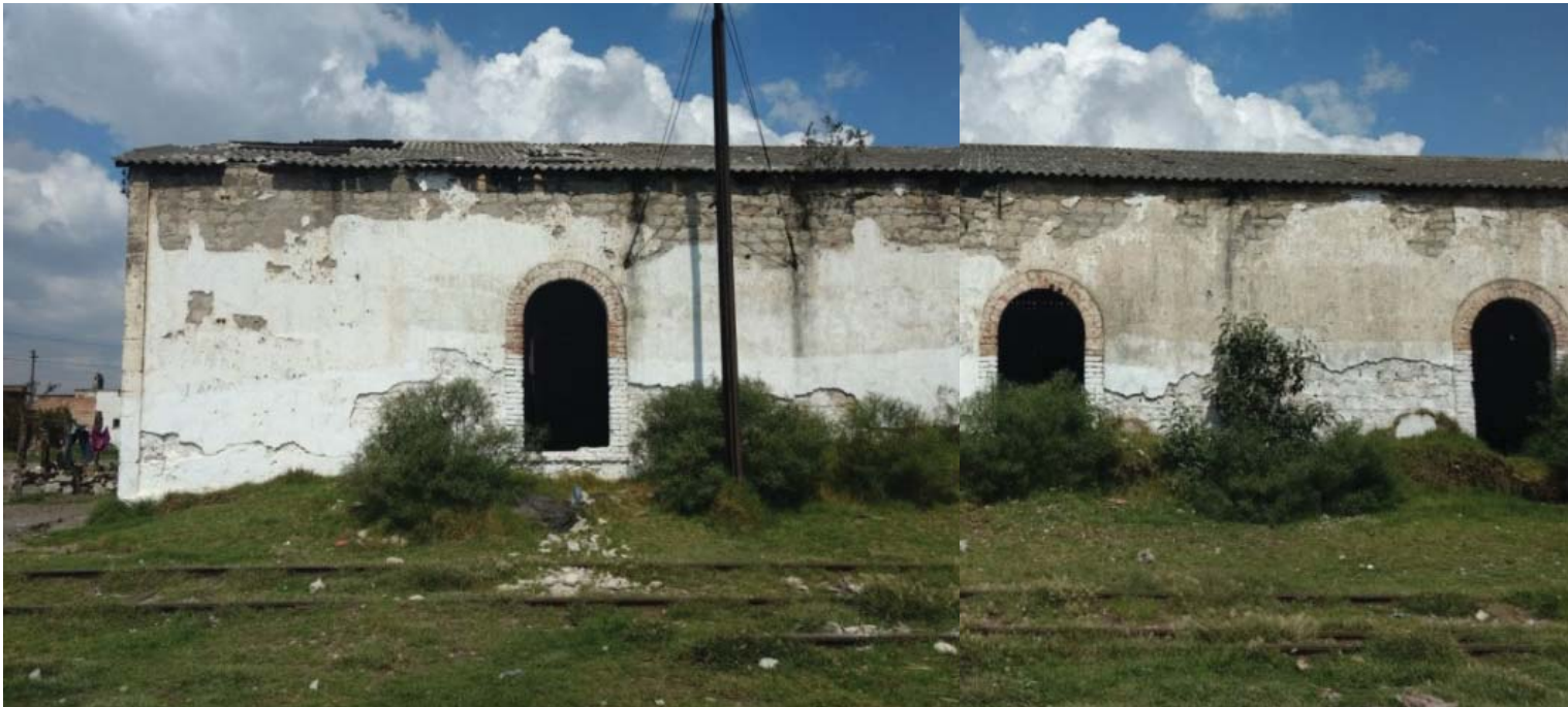
Figura 72. Larguillo lateral de Casa de máquinas. Fuente: Elaboración de la autora
