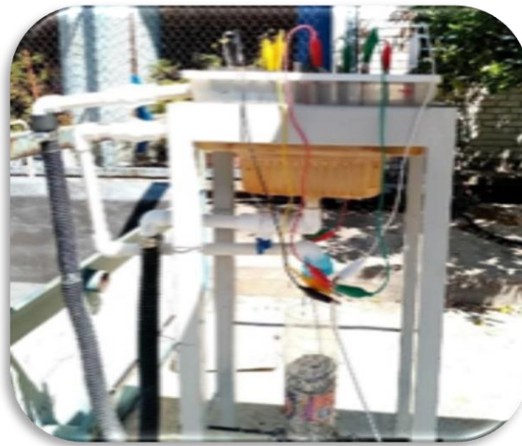
Figura 13 Conexión del sistema de electrocoagulación
