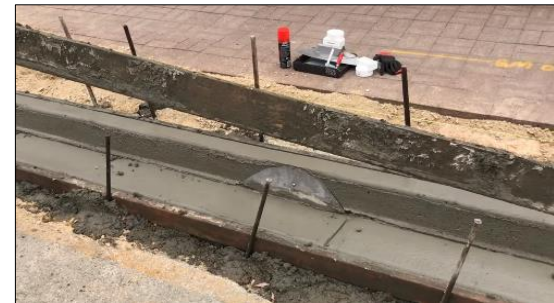
Imagen 15. Arriba podemos apreciarla cimbra de madera para colar la guarnición, con las varillas colocadas para contener los empujes y dar estructura a la cimbra y amarradas en la parte superior con alambre galvanizado. Fuente:
