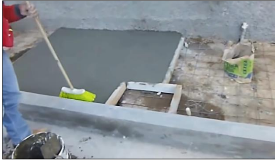
Imagen 9 Construcción de losa de acera de concreto colada en sitio reforzada con malla electrosoldada. Podemos observar la realización del cepillado. Fuente: https://www.youtube.com/watch?v=-M9RnRPbV7s
