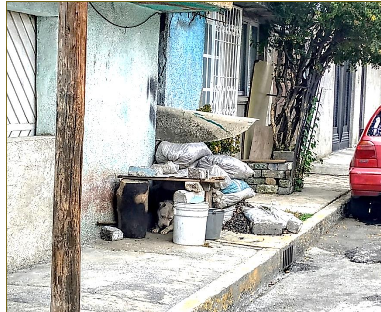
Imagen 329. Los materiales que se dejan en la banqueta obstaculizan el paso de peatones, quienes tienen que bajar al arroyo exponiendo su seguridad. En esta imagen se hace evidente que el perro está ahí para resguardar el material al igual que el acceso de la vivienda, alejando a cualquier malhechor pero también retirando a los peatones. Fuente: ©Isalia A. Paniagua, 2019.
