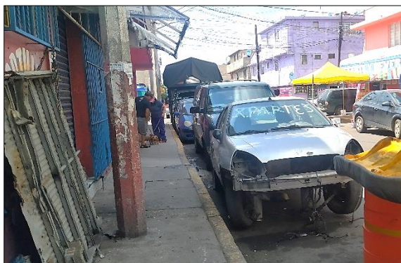
Imagen 85. Este tipo de conflictos aparecen generalmente cuando las aceras se crecen y al momento de hacerlo no se realizó un reordenamiento de mobiliario urbano e infraestructura de servicios. Fuente: ©Isalia A. Paniagua, 2019.
