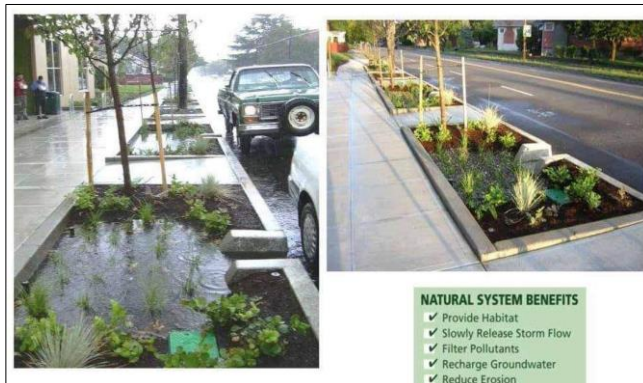
Imagen 13. En rland, Oregon y en Seattle, Washington y otras de EEUU, se diseñan y construyen aceras que atrapan el agua de lluvia. Esta es una opción de captar el agua.
