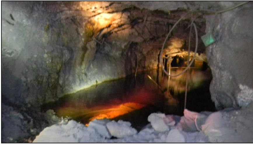
Figura 2.3 Presencia de drenaje ácido en una obra de la mina.
