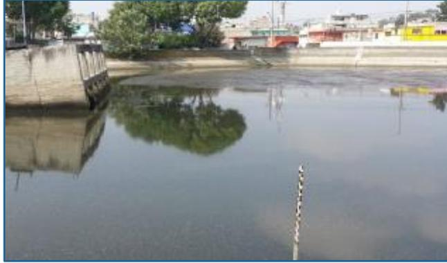
Figura 22. Tanque de almacenamiento de agua tratada, daños por hundimiento del terreno donde se encuentra la PTAR San Juan de Aragón, CdMx. (Riveros, 2013)
