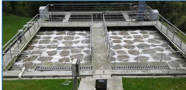
Figura 7. Tratamiento secundario mediante Lodos Activados. Tomada de (Junco, 2015)
