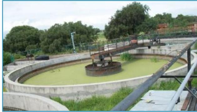
**Figura 19. Sedimentador primario fuera de servicio de la PTAR Cuatro Vientos, Ixtapaluca, Edo Mx. (Espinoza & Sepúlveda, (Trabajo de Investigación), 2015)**
