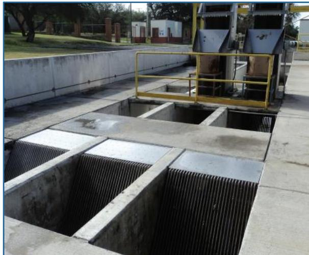
Figura 5. Cribado por medio de rejillas. Tomada de (CONAGUA, 2019)
