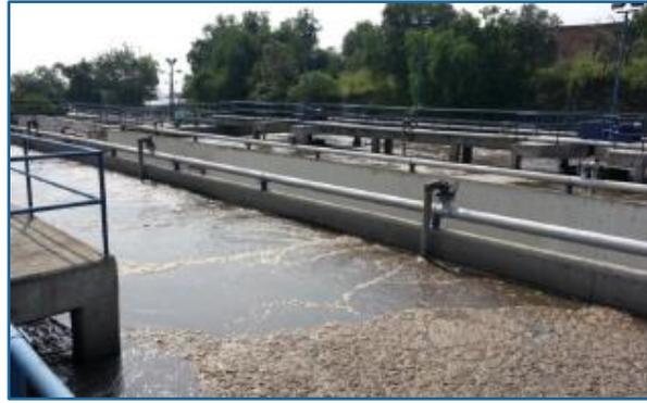
**Figura 20. Reactor biológico de la PTAR San Luis Tlaxialtmalco, con lodos en la superficie. (Riveros, 2013)**
