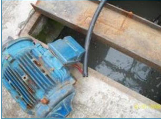
Figura 17. Equipo de bombeo expuesto en una zona riesgosa dentro de la PTAR Tlalpizahuac (Espinoza & Sepúlveda, Las Plantas de Tratamiento de Aguas Residuales del Estado de México en los Informes de la Auditoría Superior de la Federación 2012-2013, 2015)
