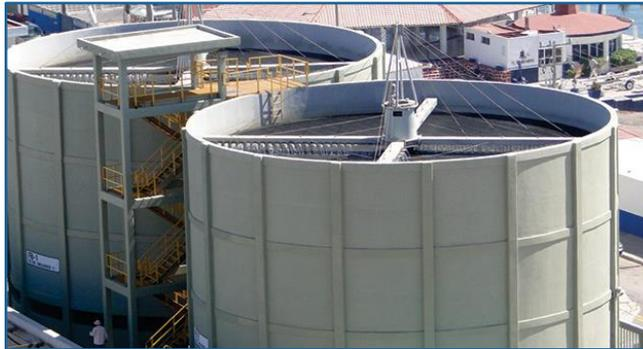
Figura 6. Sedimentadores circulares de la PTAR El Crestón Mazatlán. Tomado de (Jumapam, 2021)
