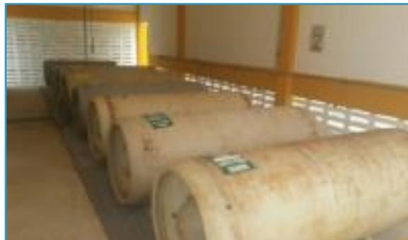
**Figura 21. Cilindros de cloro utilizados para la desinfección de agua en el tratamiento terciario. (CONAGUA, 2019)**
