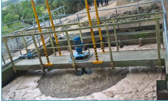
Figura 15. Ejemplo de aguas residuales en Reactor biológico con presencia de grasas y aceites en la superficie. Tomada de (Teqma, 2018)
