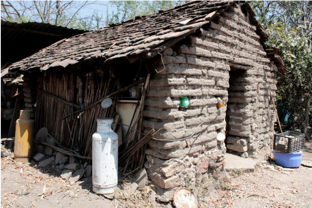
Imagen 13.- Cocina de doña Genoveva Carrales Muñoz de 86 años de edad. Este espacio tiene tres paredes de adobe y una de carrizo. Fotografía de Royma Gutiérrez.
