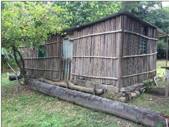
Construcción moderna sobre terraplén de tierra formado por troncos de palma de coyol, paredes de pencas (palmiches), también de palma de coyol contenidas por barras horizontales de caña de oate abiertas a la mitad, y postes o columnas interiores de palo de tinta.
