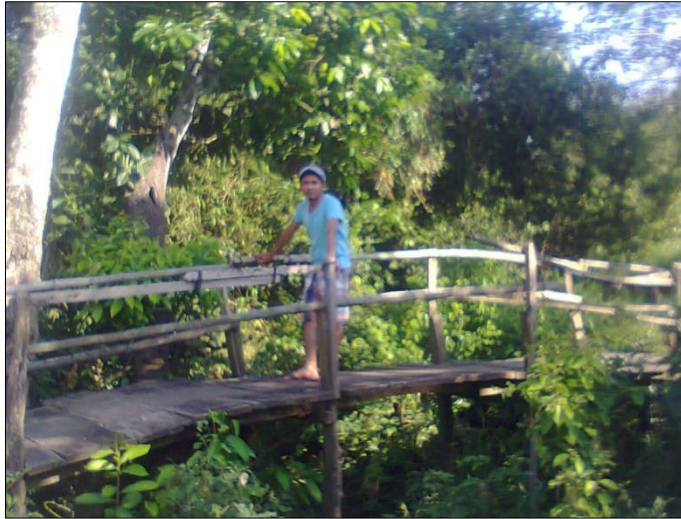
Puente para cruzar el arroyo Tenahuazapa. Material de manufactura: tablas de nacaxtle (base), cañas de otate (barandales), bejucos o enredaderas (amarre) y palos de tinta careados con sierra (columnas de soporte). Imagen del año 2010.
