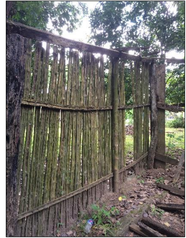
Construcción moderna con cañas de oate abiertas a la mitad (vista interior).
