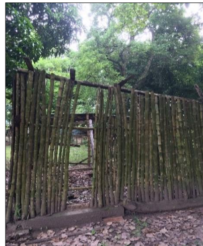
Fig. 4.33. Construcción moderna hecha con cañas de otate abiertas a la mitad. Fotografía del autor.
