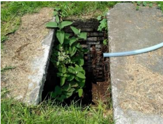
Figura 20. Fosa detrás del módulo de enseñanza cunícola. CEIEPAv, 2018.
