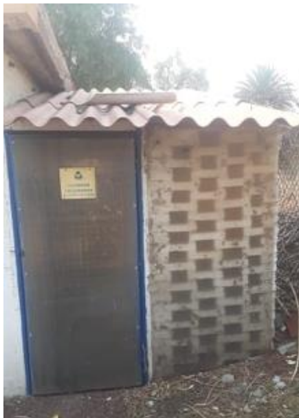
Figura 14. Vista frontal del almacén de residuos peligrosos. CEIEPAv, 2019. Fotografía: Angelina Mendoza Carrera
