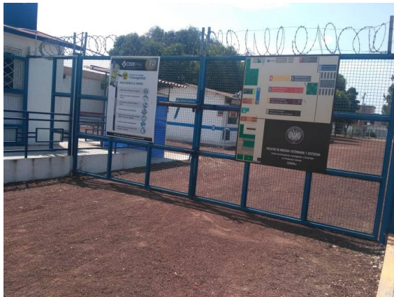
Figura 8. Reja que separa los módulos de producción de oficinas y vestidores. CEIEPAv, 2018. Fotografía: Angelina Mendoza Carrera.
