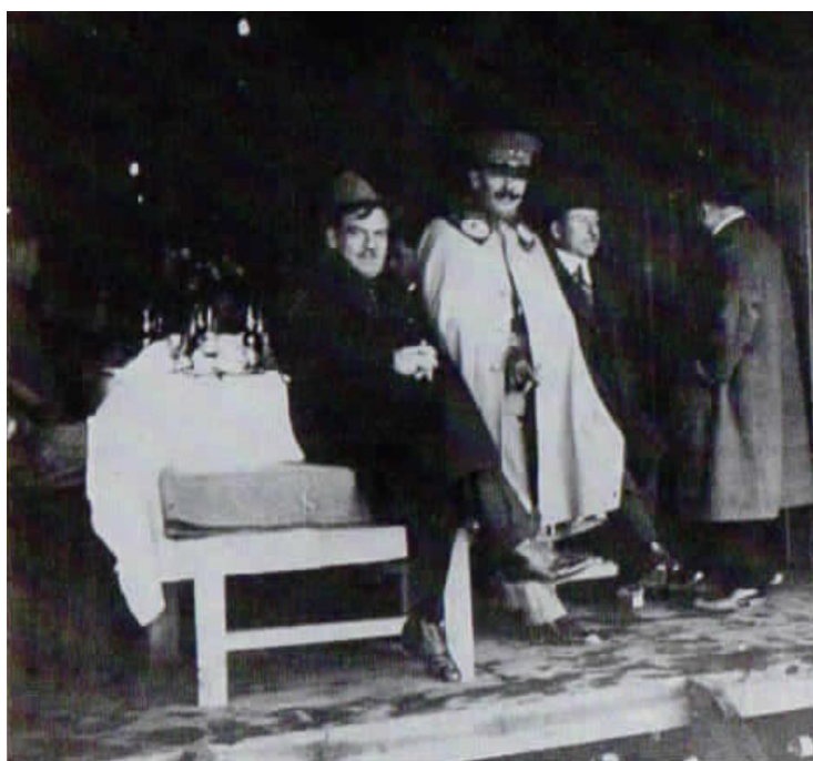
El presidente pernoctó en el campamento de Llano Grande, para supervisar los trabajos previos a la inauguración de la carretera (Macías, Carlos, 1996).
