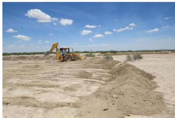
**Figura 4-7. Trazo de curvas a nivel y construcción de bordos semicirculares.**
