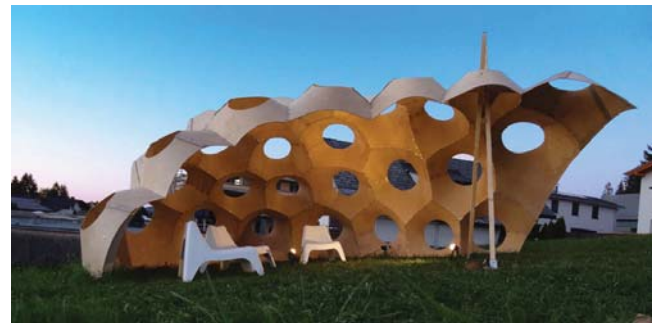
El "Pabellón para un verano" fue diseñado por Manuel Fabian Hartmann y su equipo que asistieron a la asignatura "Diseño y construcción" en la Universidad de Innsbruck en el período de verano de 2013. El objetivo era construir un pabellón ligero temporal de madera, por solo un verano, que cueste menos de 1500 euros. También era importante realizar la estructura completa a mano sin el uso de cnc o técnicas robóticas. El lugar de ubicación del pabellón es una colina en el centro de Alberschwende en Vorarlberg, Austria.
