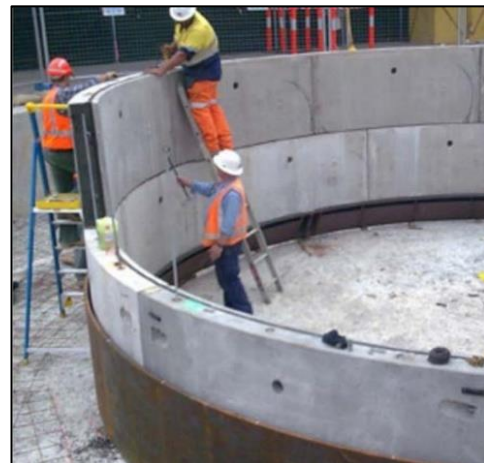
Imagen 2.3. Armado de anillos prefabricados.
