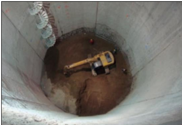
Imagen 2.5. Excavación en seco del núcleo.
