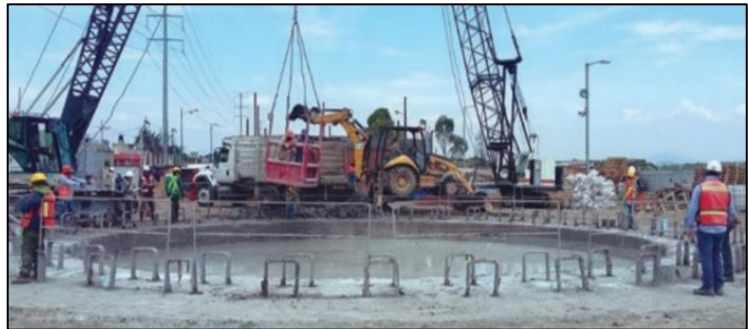
Imagen 2.20. "Alberca" de lodo bentonítico que sustituyó el suelo del núcleo.
