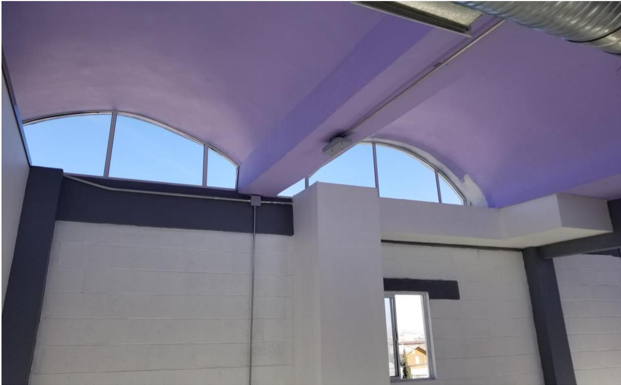
Fig. 2.60 interior de una cubierta abovedada. Fuente Gamez 2019
