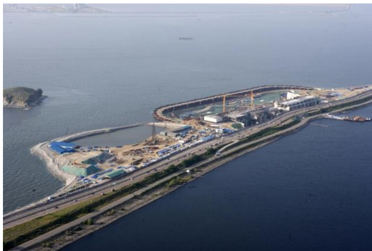
Ilustración 3. Central mareomotriz de Sihwa Lake, Corea del Sur, con 254 MW de generación eléctrica, (Recurso electrónico, 2020).
