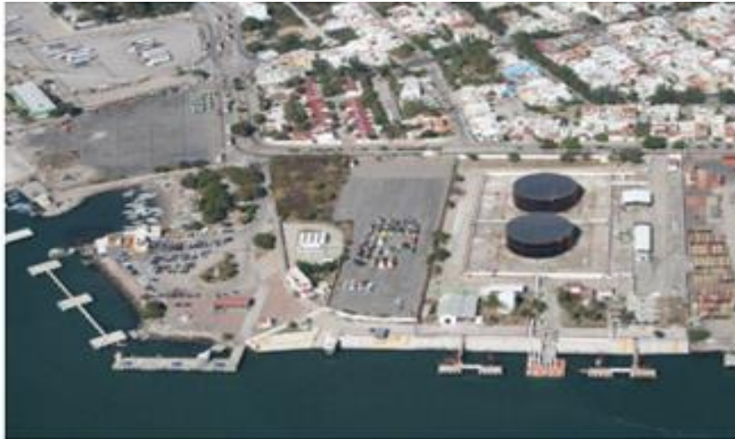
Figura 19 Vista de la Terminal de Fluidos (API Mazatlán, 2015).
