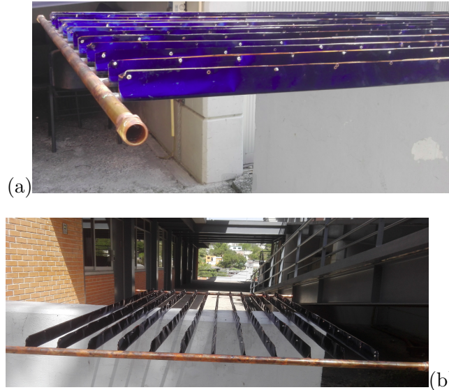
Figura 5.4: Absorbedor del captador solar CPC.(a) Cabezal tubo-aleta. (b) Arreglo completo.
