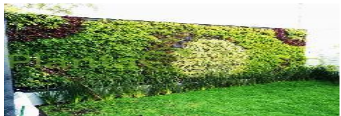
Figura 9. Ejemplo de sistema de naturación colocado en un muro. (Tomado de: https://plantaoxigeno.com/portfolios/pared-verde-residencial/ consultado el 14/11/2019)
