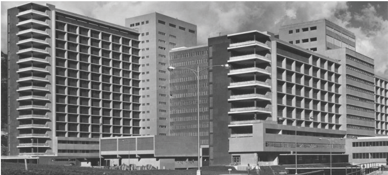
Foto 59. Nula integración de la naturaleza al exterior del Hospital Militar “Dr. Carlos Arvelo” Caracas, Venezuela. Recuperado de https://bit.ly/32xgmH5
