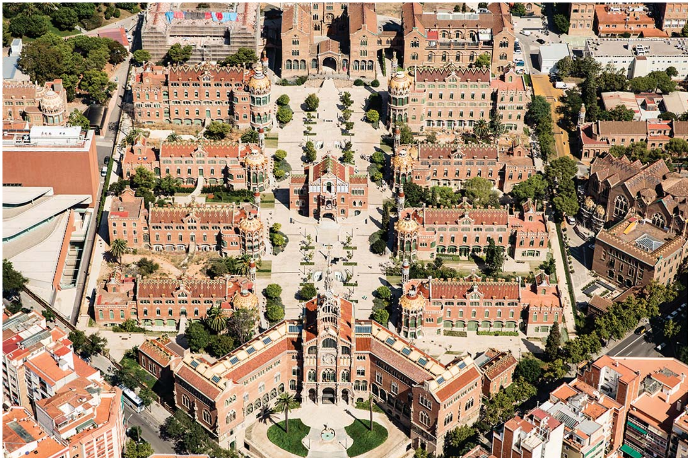
Foto 56. Integración de naturaleza en el conjunto del Hospital de la Santa Creu i Sant Pau, en Barcelona, España, diseñado por Lluís Domènech i Montaner. Recuperado de http://bit.ly/2NWWHfM
