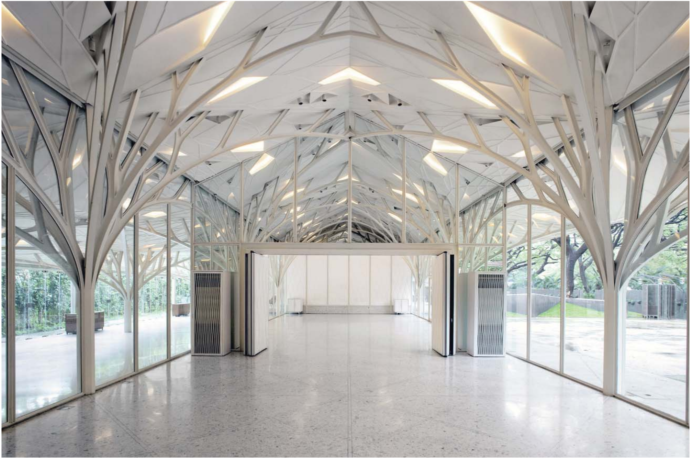
Foto 97. Integración del sistema Lindenmayer en la representación de árboles en el Tote Restaurant, ubicado en Bombay India, diseñado por Serie Architects. Recuperado de http://bit.ly/3arpNvm
