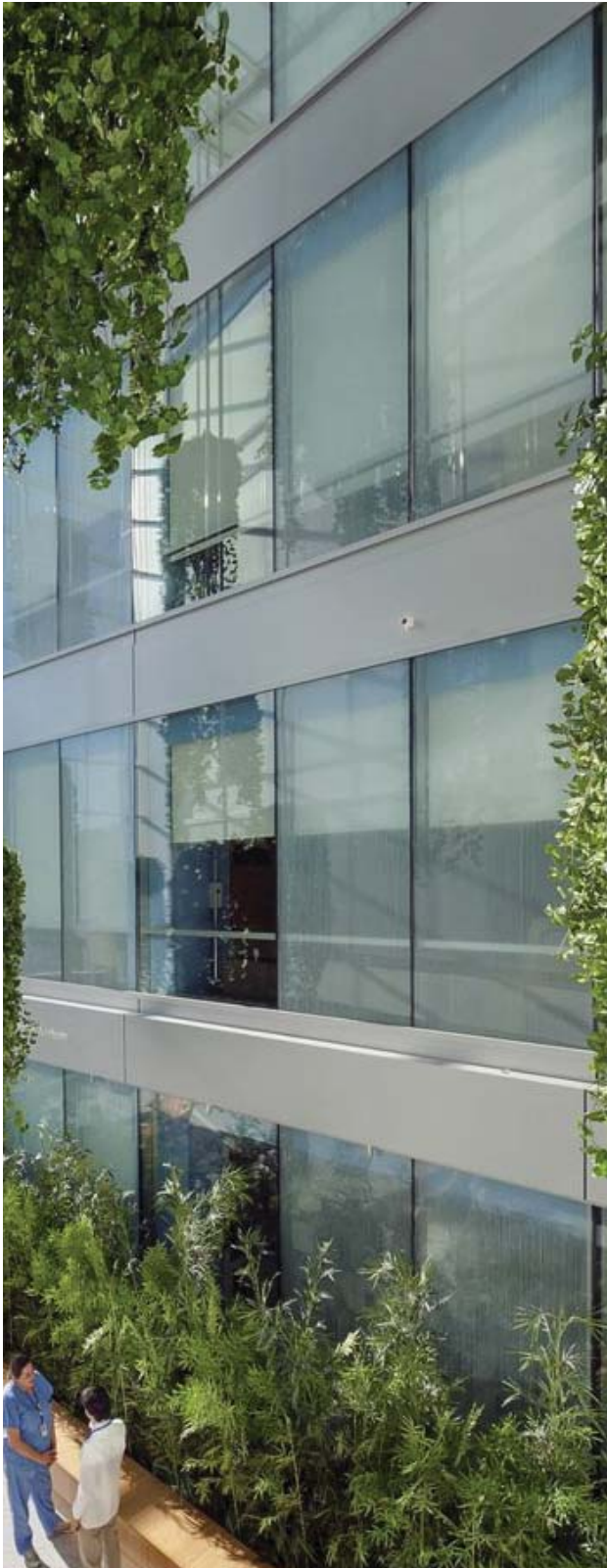
Foto 5. Naturaleza colgante, jardineras interiores, iluminación natural y diseño de mobiliario en el Palo Alto Medical Foundation's San Carlos Center, en California EUA, diseñado por NBBJ. Recuperado de https://bit.ly/3cw1mPQ
