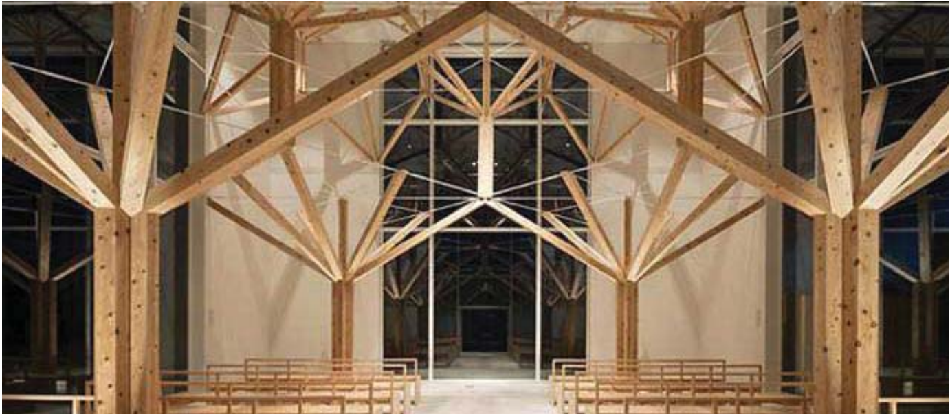
Foto 92. Ramas de un árbol representados de forma estructural en la Capilla Agri, en Nagasaki-Shi Japón, diseñado por Yu Momoeda Architecture Office. Recuperado de http://bit.ly/3oCUQZZ
