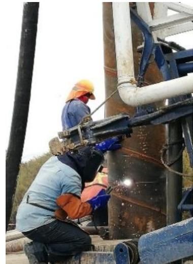
Ilustración 48 Unión de tubería lisa con soldadura de filete. Fuente: Elaboración propia.
