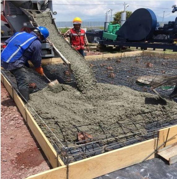
*Ilustración 24 Vaciado de concreto para losa de cimentación instalada sobre el terreno nivelado.*
