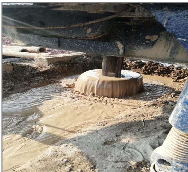
*Ilustración 29 Circulación de fluido de perforación.
