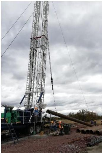
Ilustración 46 Izaje de tubería lisa. Fuente: Elaboración propia.
