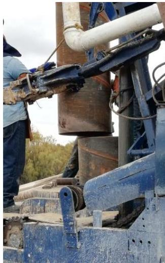
Ilustración 47 Acoplamiento de tubería lisa. Fuente: Elaboración propia.
