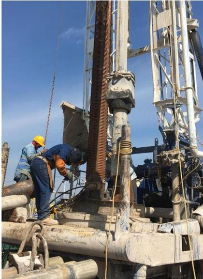
*Ilustración 56 Colocación de tubería ranurada. Fuente: Elaboración propia.*
