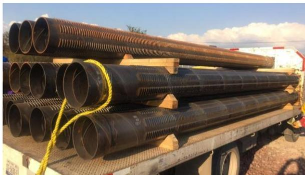
*Ilustración 53 Suministro de tubería ranurada. Fuente: Elaboración propia.*
