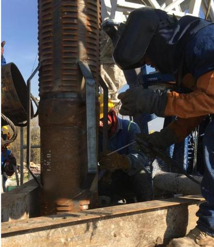
*Ilustración 54 Colocación de tubería ranurada.*
