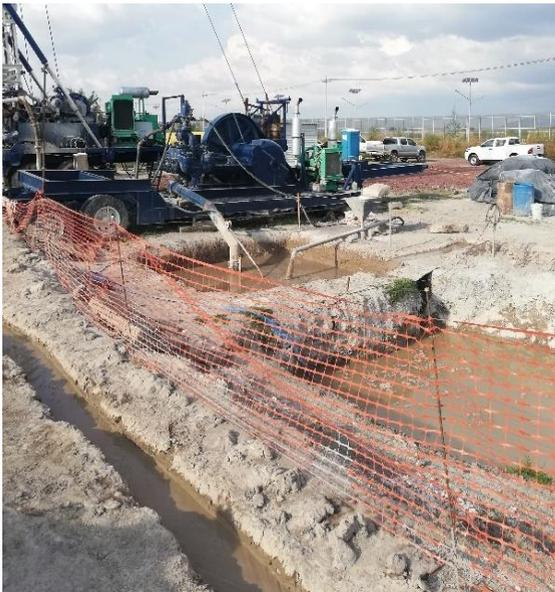
*Ilustración 18 Fosa de fluido de perforación*
