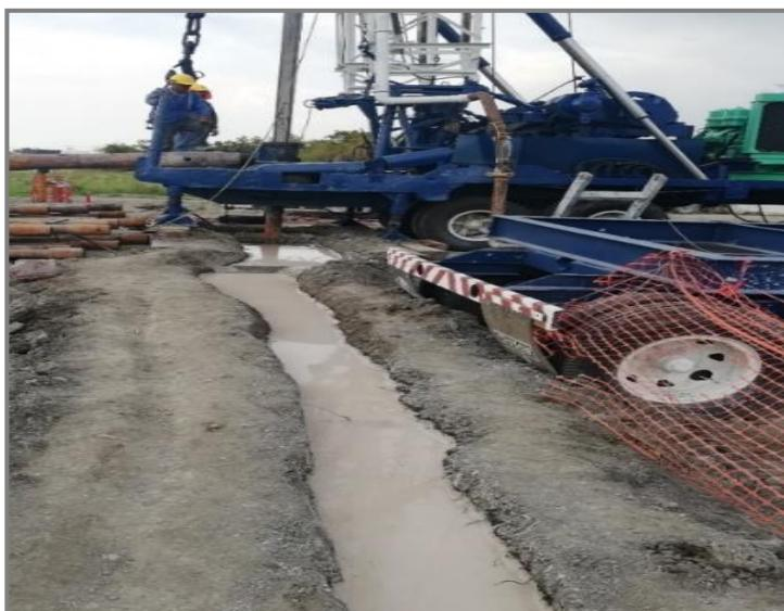
*Ilustración 28 Canal conductor del fluido de perforación.
