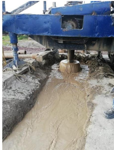
Ilustración 43 Retorno de fluido de perforación.
