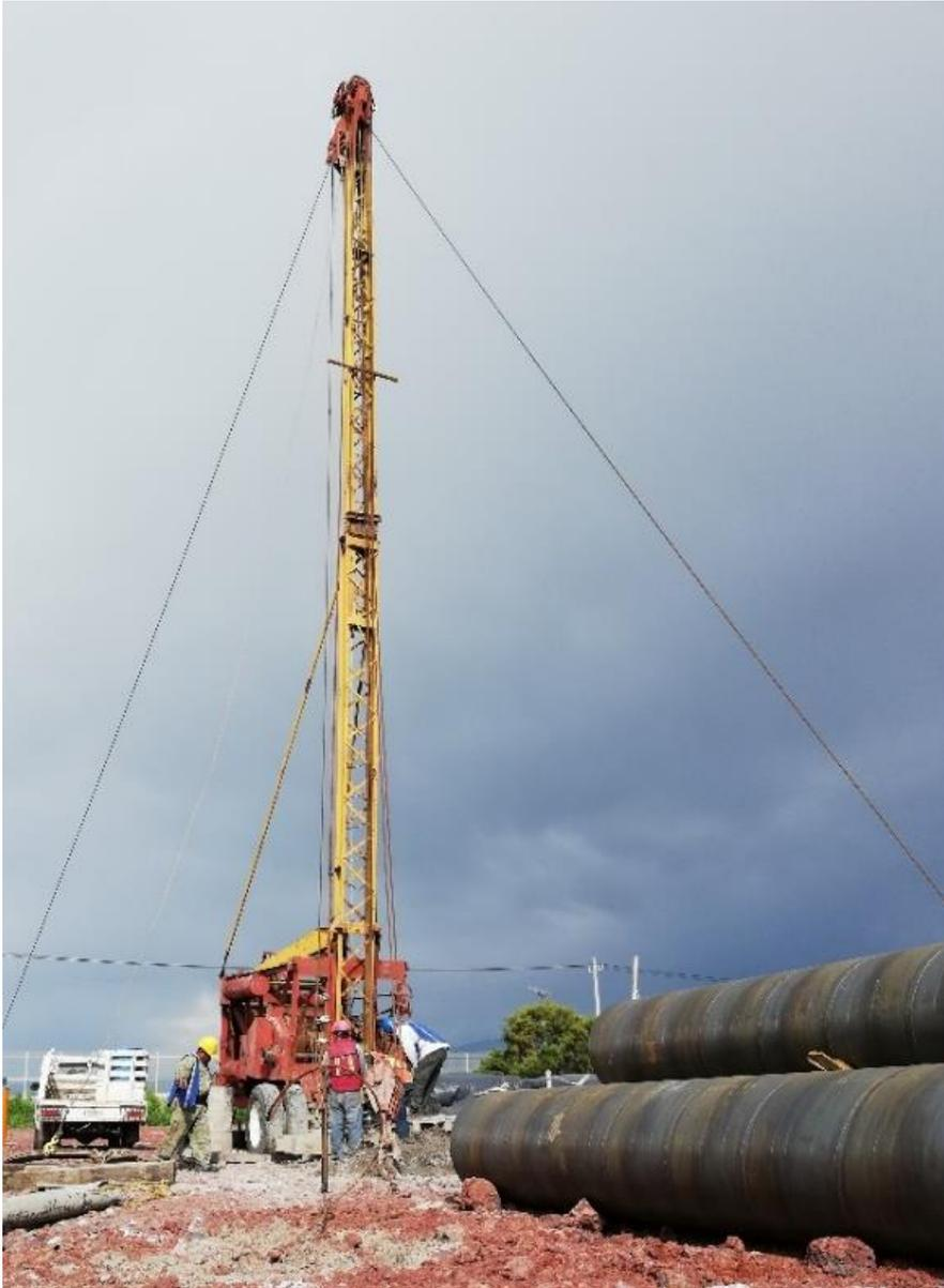
*Ilustración 15 Equipo de perforación tipo percusión.
