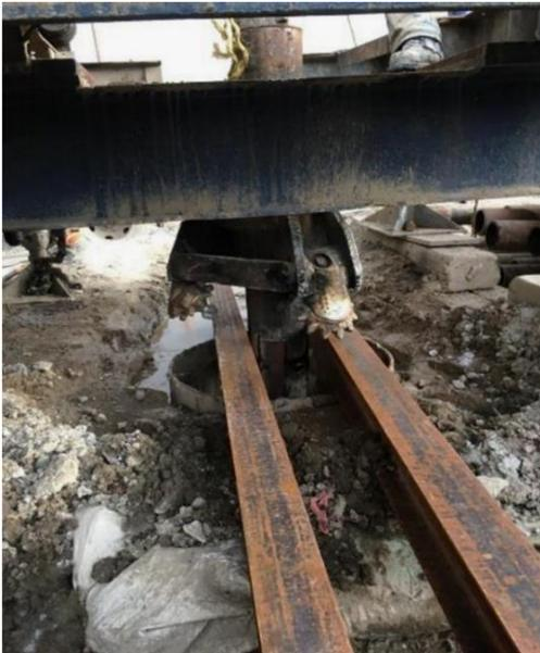
Ilustración 42 Colocación de barrena tricónica.
