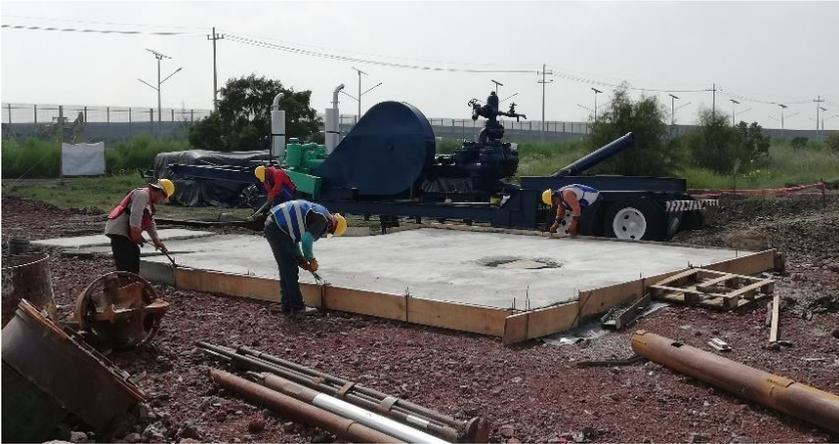
*Ilustración 19 Preliminar. Losa de cimentación. Fuente: Elaboración propia.*
