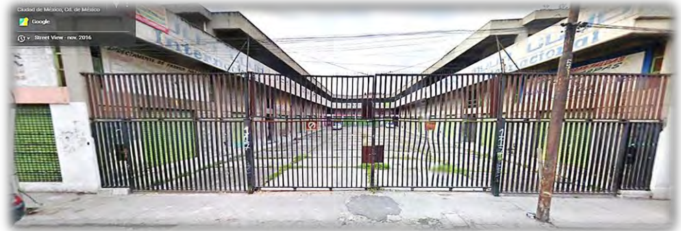
Imagen 1.5. Acceso al predio Granada 121. Fuente: Portal de internet de Google maps, editada posteriormente
