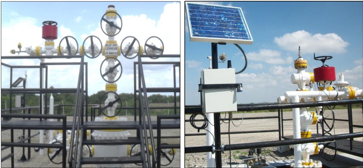
Figura 1.21 Instalación de la Válvula motora
