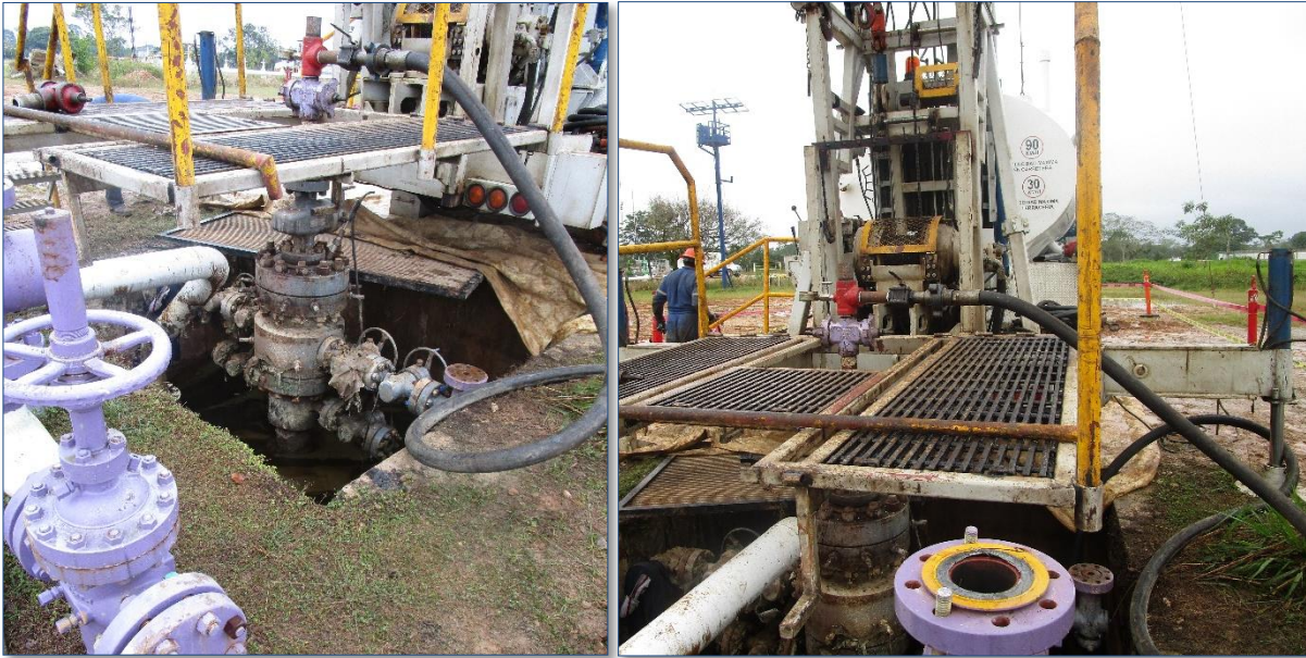
Figura 4.19 Despresurización de TP y TR
