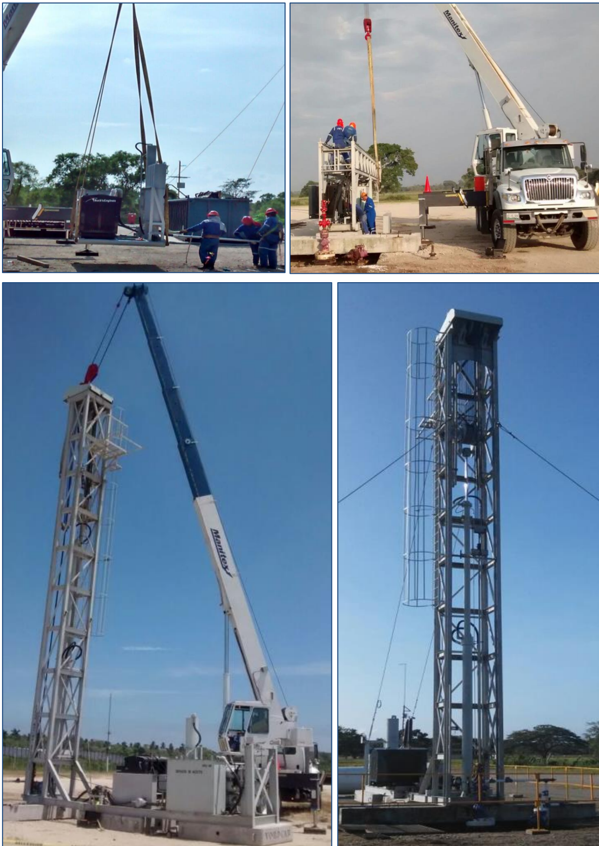
Figura 4.19 Equipo de la Unidad Hidroneumática de Carrera Larga en el pozo M-4D operando
