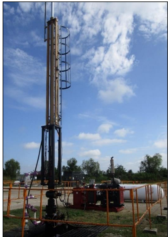
Figura 1.8 Unidad Hidroneumática (Tieben)
