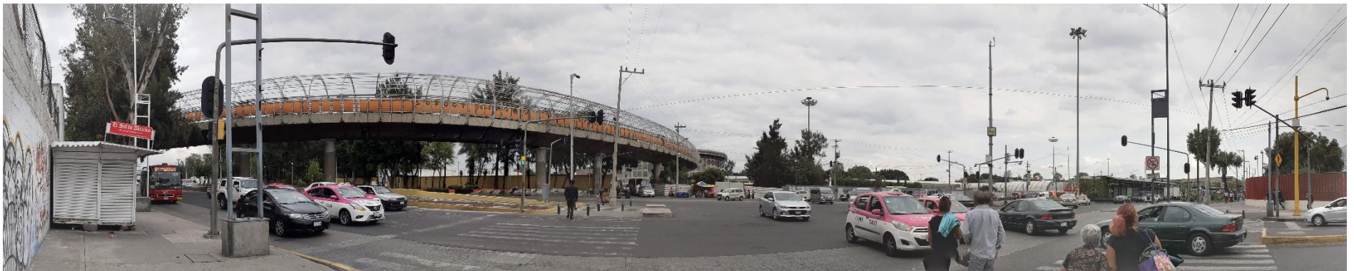
Panorámica 2 Vista del metro y entrada a la TAPO desde Eje 3 Oriente "Ing. Eduardo Molina" y calle Artilleros. Foto de autoría propia.
