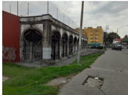
Fotografía 4 Vista de la antigua Garita de San Lázaro visto desde Eje 2 y Emiliano Zapata. Foto de autoría propia.
