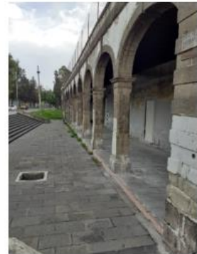
Fotografía 5 Vista de la antigua Garita de San Lázaro visto desde Eje 2. Dirección Norte-Sur Foto de autoría propia.
