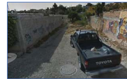
Zonas de deterioro
