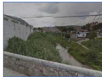
Zonas de deterioro
