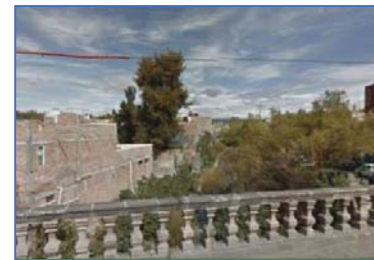
Zonas de deterioro
