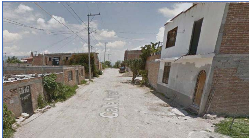
Imagen 12. Zona de deterioro visual tipo en las zonas periféricas, mala imagen urbana y falta de carpeta asfáltica en vialidad.
