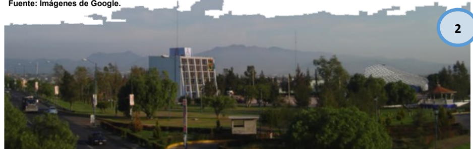
Vista lateral derecha del contexto existente. Fuente: Imágenes de Google.
