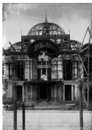
P. de Bellas Artes en Construcción, 1844. Fuente: Imágenes de Google.
