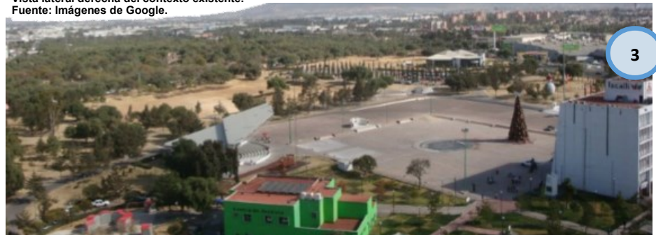
Vista aérea hacia el predio y contexto existente. Conjunto actual. Fuente: Imágenes de Google.
