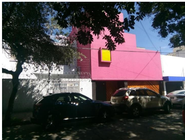
Figura 165. Fachada de la casa Gilardi. Fuente: (D.V. 2018).
