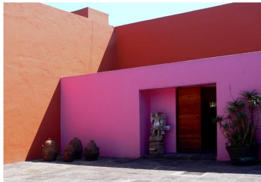
Figura 21. Acceso vivienda, casa Prieto López. Fuente: (Beaudouin 2013).
