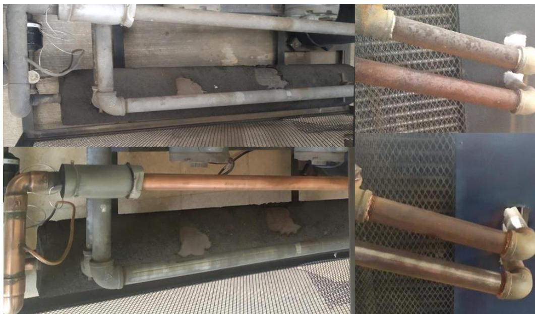
*Figura 4.5 Comparativa del estado de la tubería antes (arriba.) y después (abajo) de la limpieza.*
