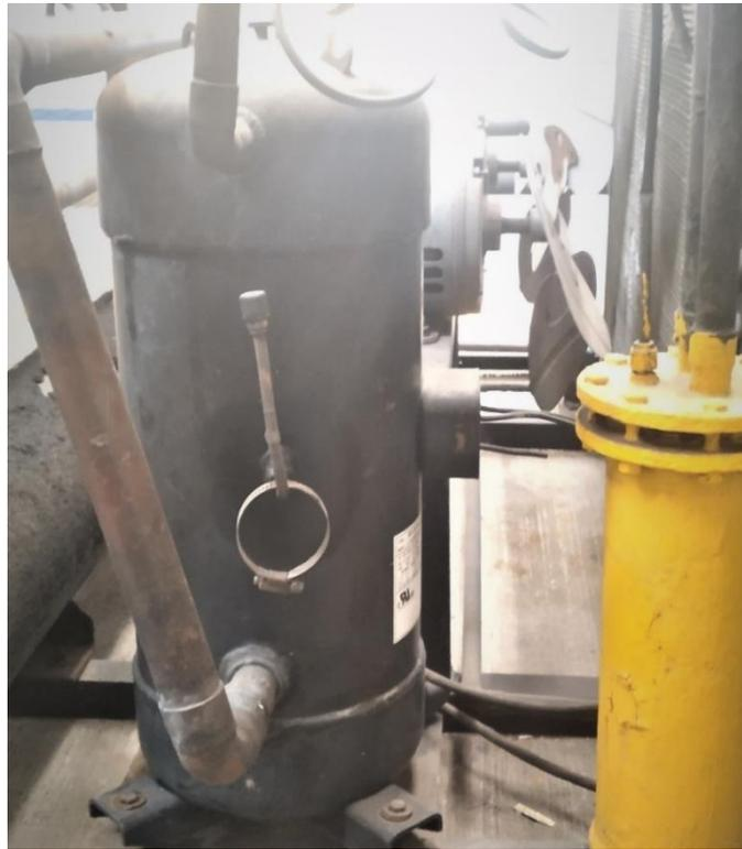
**Figura 2.6** *Compresor marca Sanyo tipo scroll*
