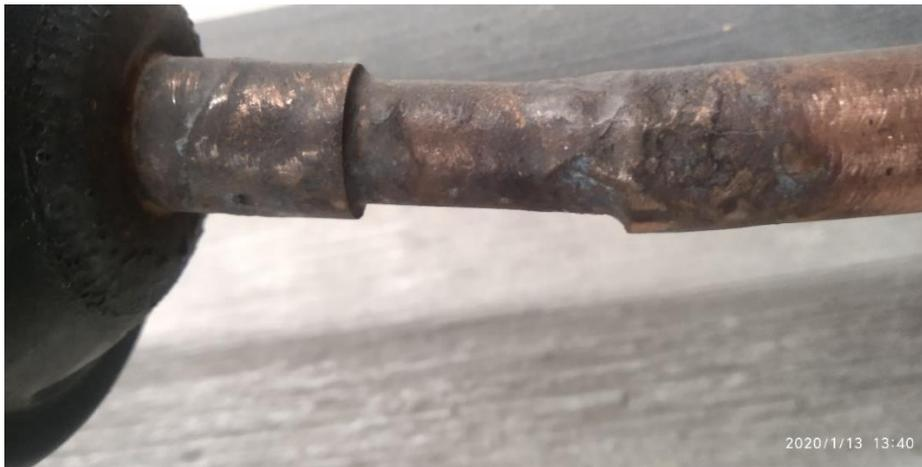
**Figura 2.15** Conexiones existentes en el filtro secador
