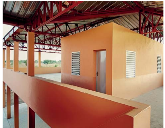
Vista segundo nivel.
