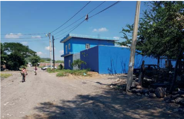
6. Vista de calle Lázaro Cárdenas.
