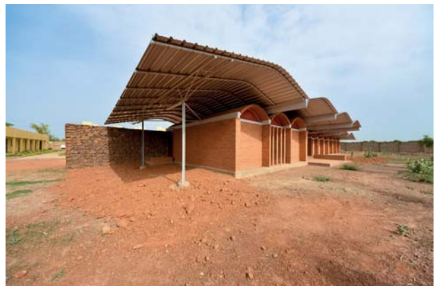
Vista exterior, doble cubierta.
