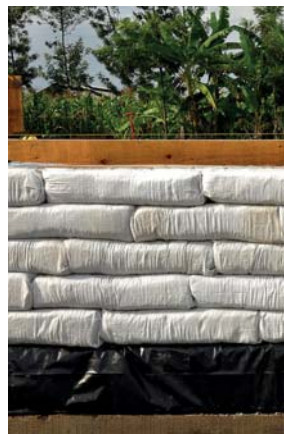
Muro de bolsas de tierra.
