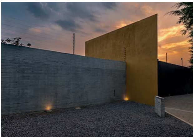
Vista de fachada.
