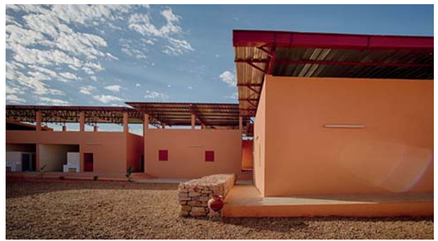
Vista exterior desde patio central.
