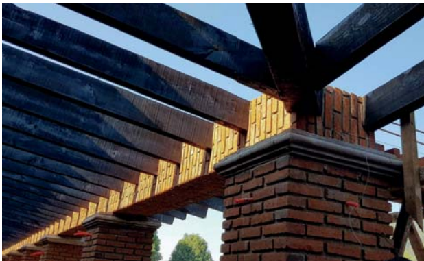
Vista de traveses de madera recargadas en traveses forrada de ladrillo.
