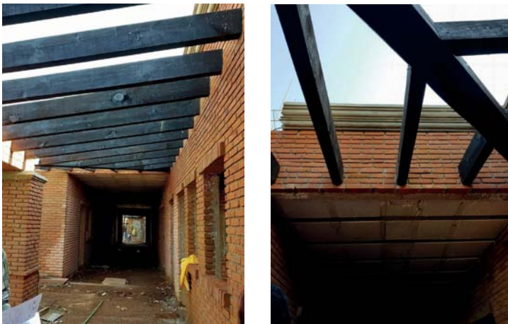
Vista de la circulación y pergolado fuera de las celdas.
