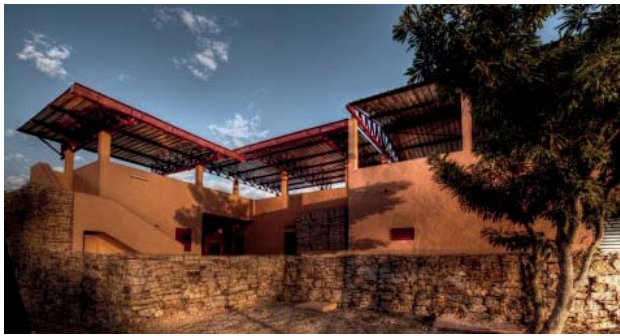
Vista exterior de dormitorios.
