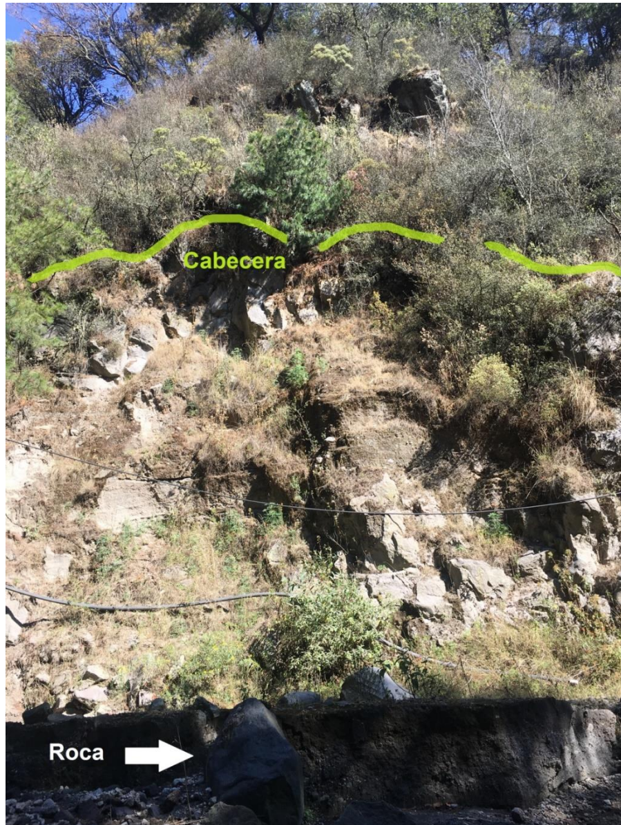
Figura 4. Caída de roca. Localizado a 2,969 m.s.n.m, en el margen izquierdo del cauce principal. El deslizamiento tiene 24 m de altura, 53 m de longitud y 2 m de profundidad.
