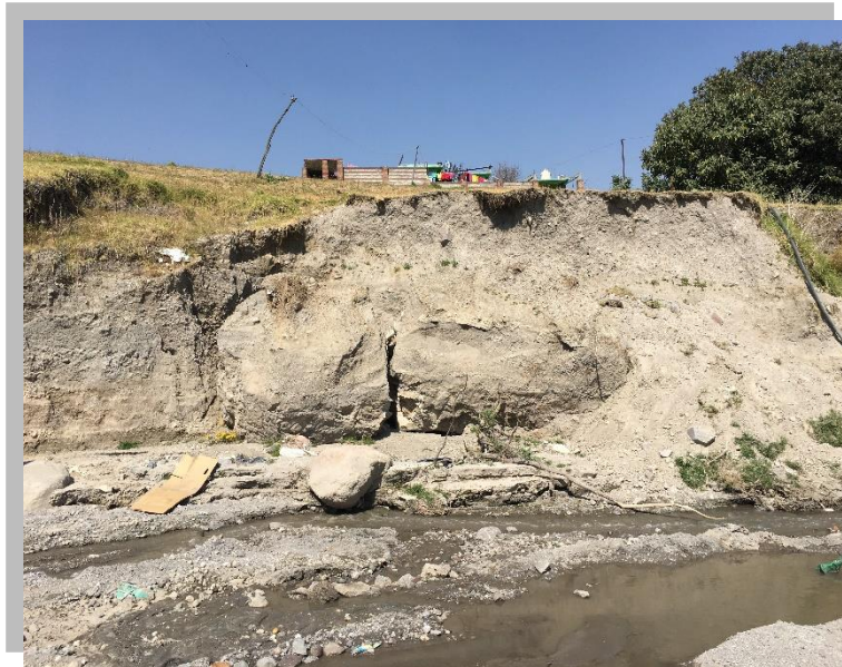
Figura 18. Deslizamiento de escombros en la comunidad de San Francisco Putla. Localizado a 2,773 m.s.n.m, sobre el cauce principal correspondiente al margen izquierdo y presenta una altura de 3.6 m, 29.5 m de largo y 1 m de profundidad.
