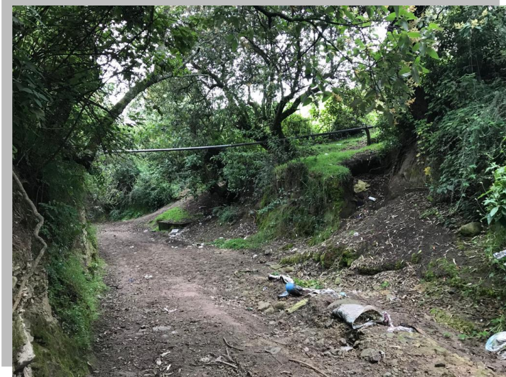
Figura 29. Punto de verificación A ; deslizamiento de escombros. Con presencia de materiales leñosos.
