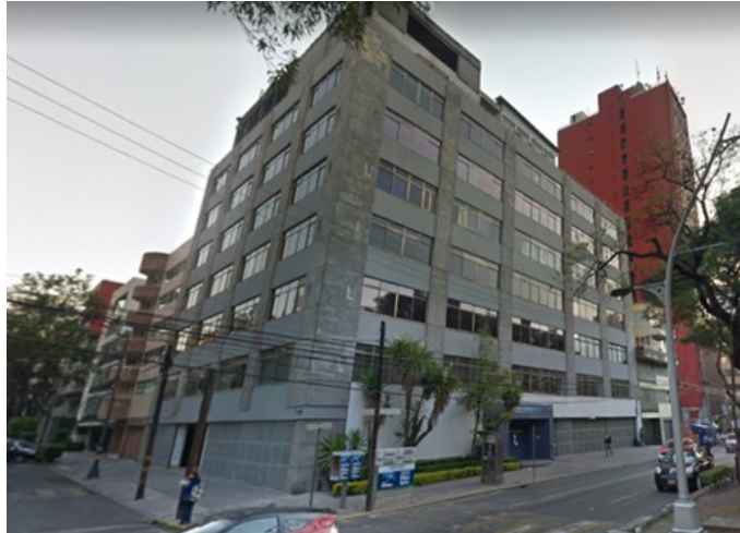
Figura 7. Estado del Edificio E. Nacional antes de la renovación que inicio en 2016.
