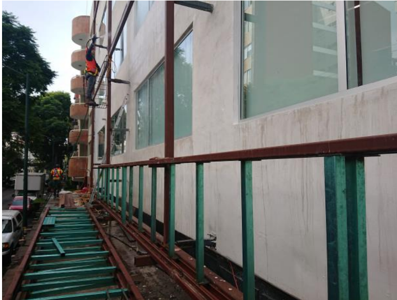
Figura 26. Realización de la prueba tipo 2. Sobre la fachada lateral (Poniente).
