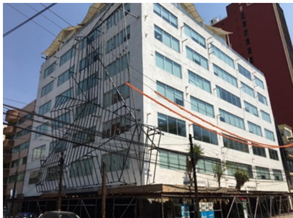
Figura 3. Estado actual del Edificio E. Nacional.
