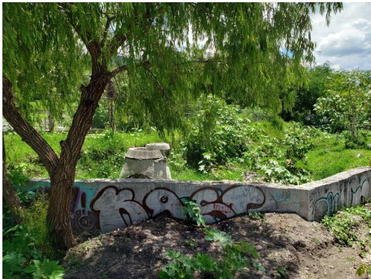
Fig.12 Respiradero de desagüe de aguas residuales de la planta tratadora en mal estado con el canal obstruido por vegetación.
