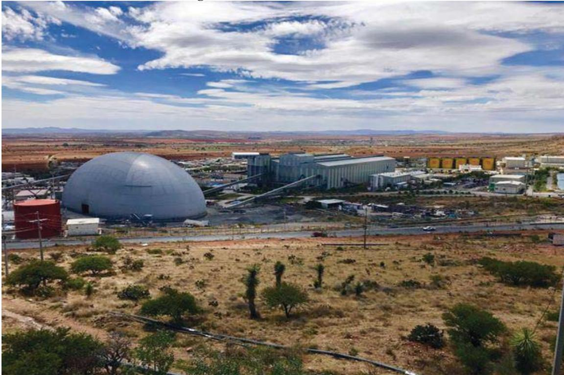
Nota: Entre otras instalaciones, de izquierda a derecha se aprecia el domo que cubre la pila de almacenamiento (*stock-pile*), las bandas de transportación, las plantas de beneficio gemelas (Saucito I y Saucito II) y los tanques de lixiviación (en color amarillo) de la planta de pirritas.
