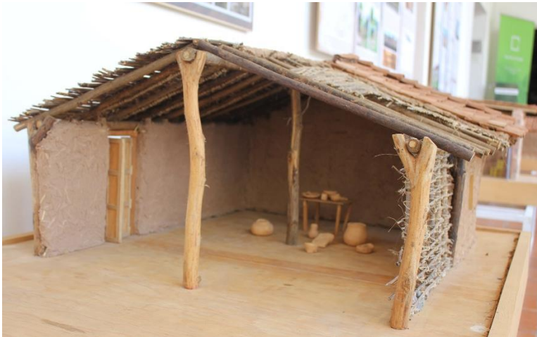
Imagen 4.27.- Obtenida de (Laboratorio de Procedimientos y Sistemas Constructivos Tradicionales, 2019). Vivienda de bahareque en Ixtepec, Oaxaca.
