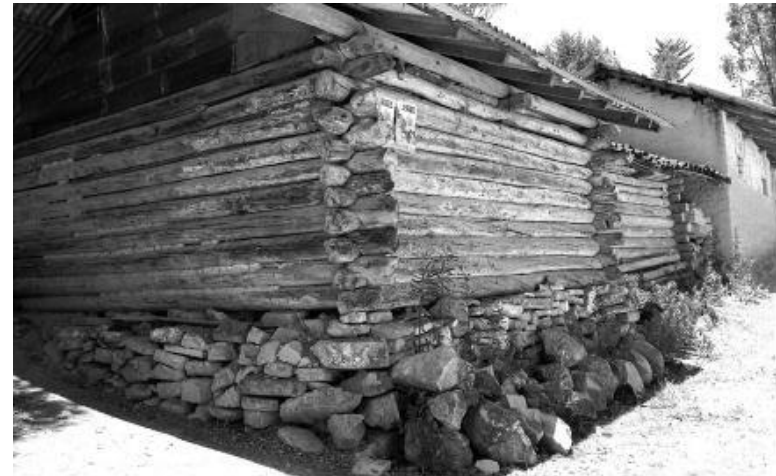
Imagen 4.20.- Obtenida de (De Leo, 2015). Detalle de cimentación de piedra y muros de troncos. San Pedro Yucunama, Oaxaca.
