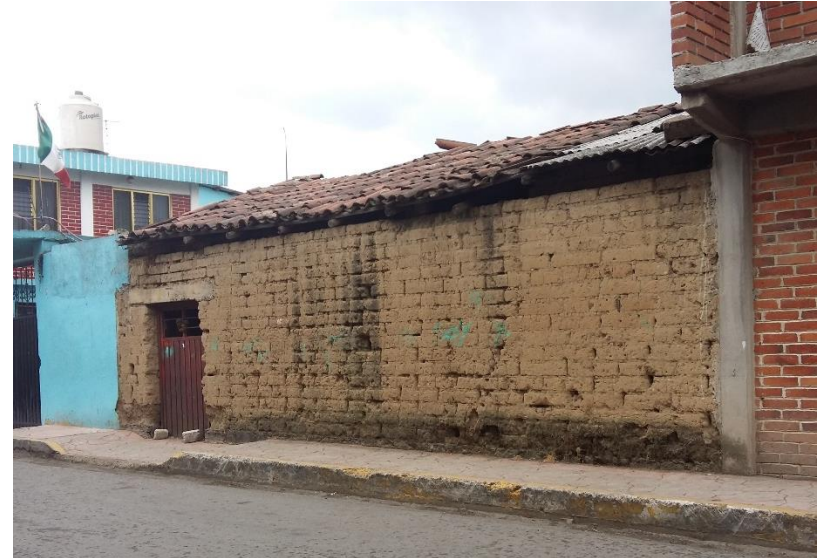
Imagen 4.26.- Fotografía tomada por la autora. Vivienda vernácula con muros de adobe en Xalatlaco, Estado de México.
